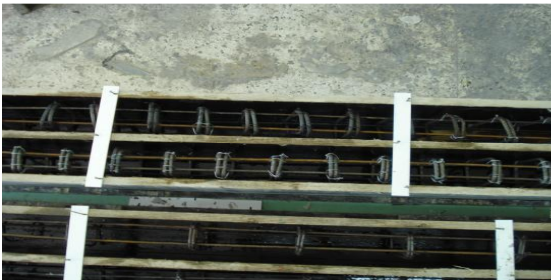
Διακρίνεται ο εγκάρσιος και ο διαμήκης οπλισμός τοποθετημένος σε καλούπια κατασκευής δοκαριών που προορίζονται για πείραμα μελέτης.
