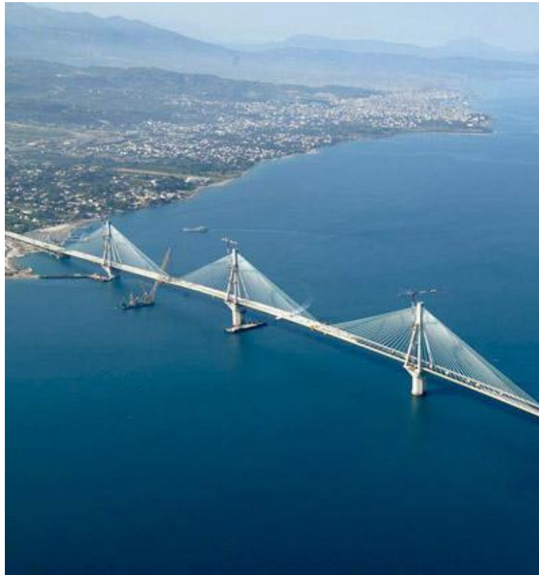
Εικόνα (6) Καλωδιωτή γέφυρα Ρίου-Αντιρρίου
