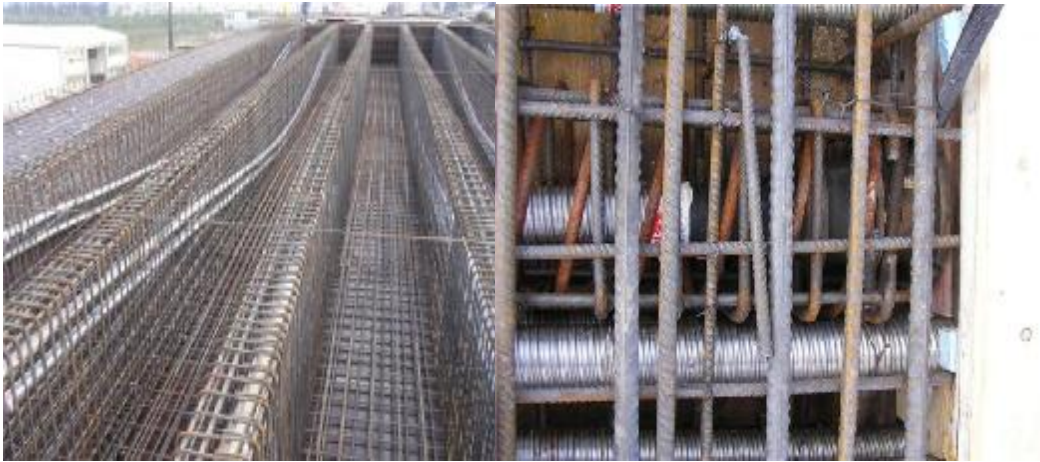
Τοποθετημένος χαλαρός οπλισμός και οπλισμός προέντασης σε πλακοδοκό γέφυρας
