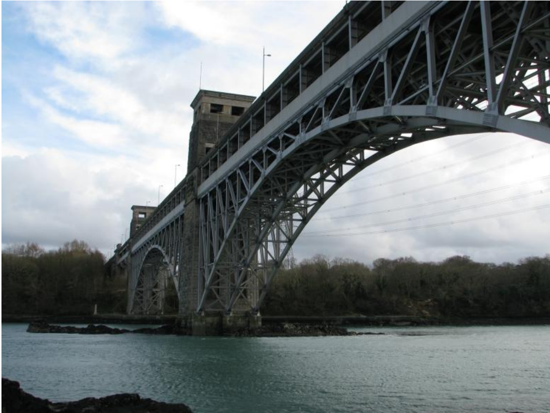
Εικόνα (4) Γέφυρα Britannia στην Αγγλία
