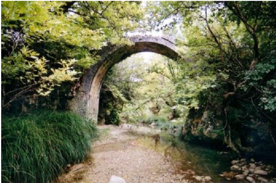
Εικόνα (2) Τοξωτή γέφυρα στο νομό Θεσπρωτίας
