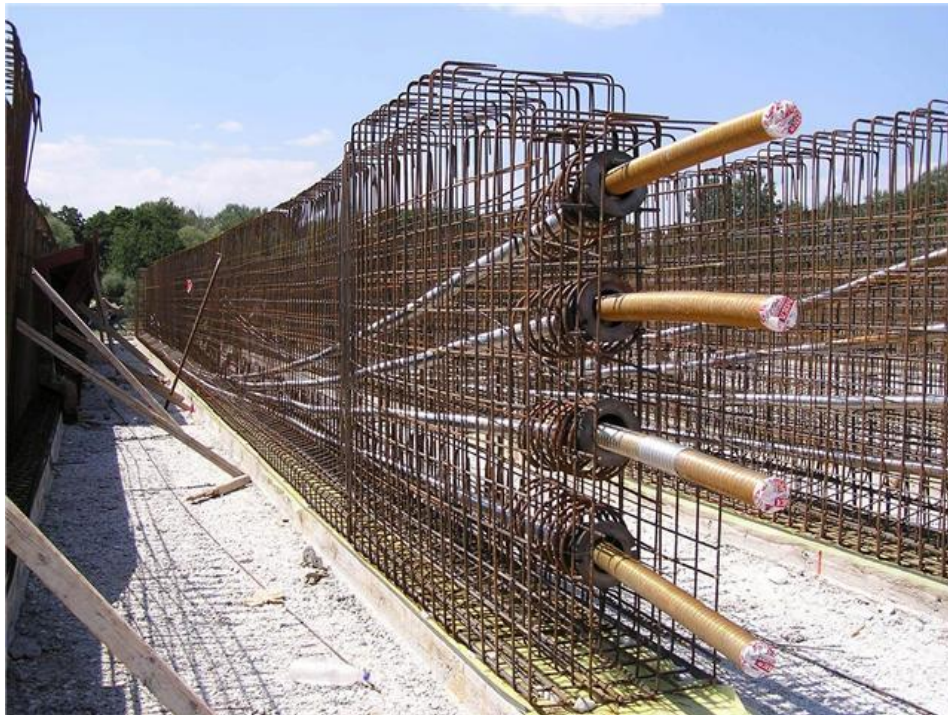
Τοποθέτηση χάλυβα προέντασης με τη μέθοδο εσωτερικής προέντασης μέσω τεθλασμένου χάλυβα .
