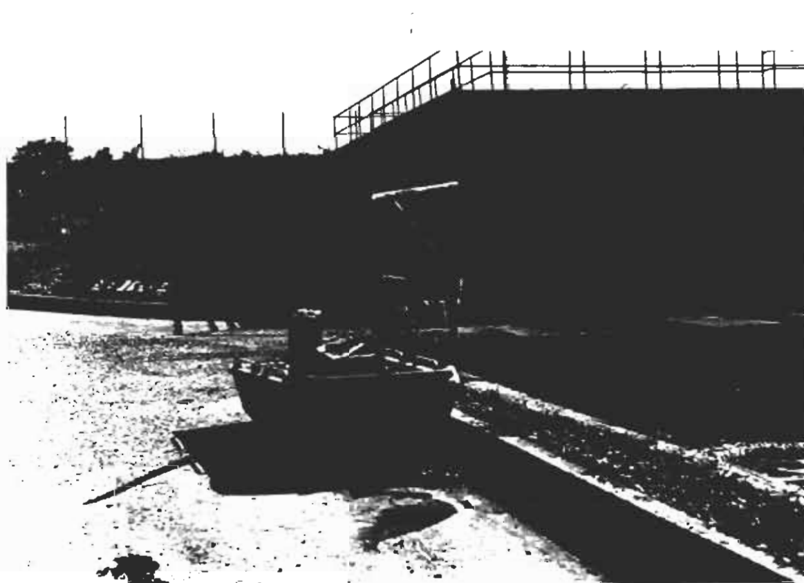
Εικ 6 : Αεριστήρας Για Την Ανάδευση Των Αποβλήτων Στην Δεξαμενή Αερισμού.
