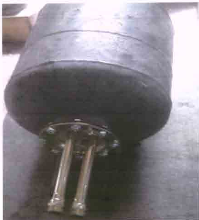
"Αντίσταση διπλής ενέργειας βιδωμένη στο μπόιλερ"
