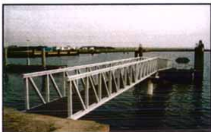
Σχήμα 3.2.1 Γέφυρα/αποβάθρα από σύνθετα υλικά για ναυτιλιακή χρήση στην Ολλανδία.
