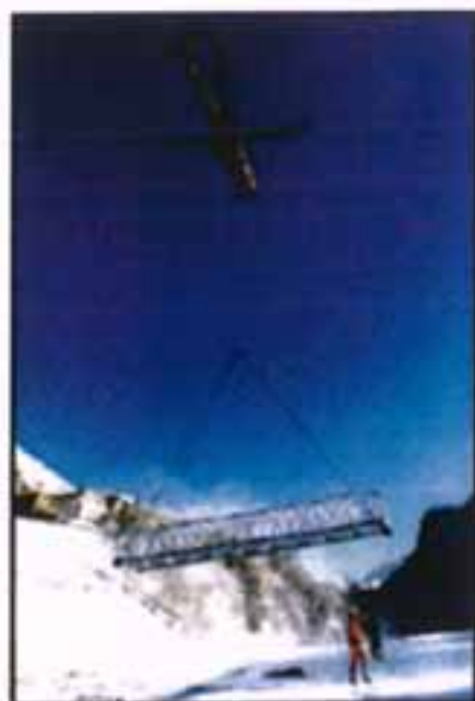
Σχήμα 4.5.2: Τοποθέτηση γέφυρας σύνθετων υλικών με ελικόπτερο στην Pontresina της Ελβετίας.
