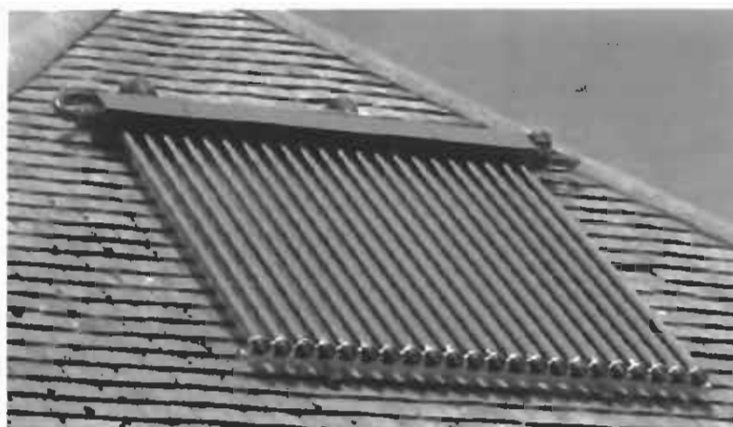
Συλλέκτης με σωλήνες κενού για κλιματισμό www.focus-solar.com/air-cond.htm
