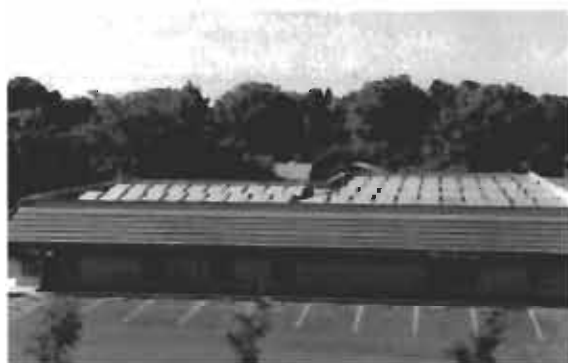
Συστοιχεία ηλιακών συλλεκτών για κλιματισμό –θέρμανση –ζεστό νερό “Courtesy of Bergquam Energy”
