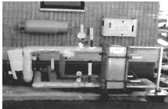
Σχήμα 1.6. Κλιματιστική συσκευή που χρησιμοποιεί θαλασσινό νερό ως ψυκτικό μέσο Από: NELHA Natural Energy Laboratory Of Hawaii Authority www.nelha.org/about/resources.html
