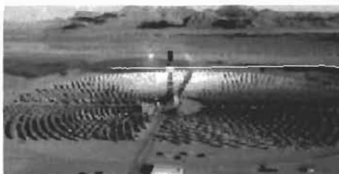
Σχήμα. 2.6: Εγκατάσταση κεντρικού δέκτη. [13]
