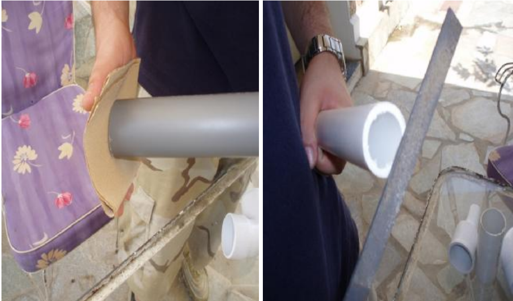
Εικόνα 43: Λείανση με σμυριδόπανο και ευθυγράμμιση με λίκμα
