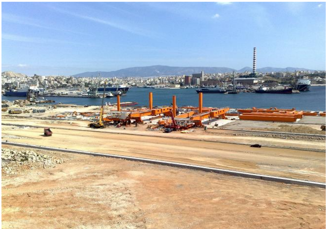
Εικόνα 2.2: Άποψη Προβλήτα Ι [1].
