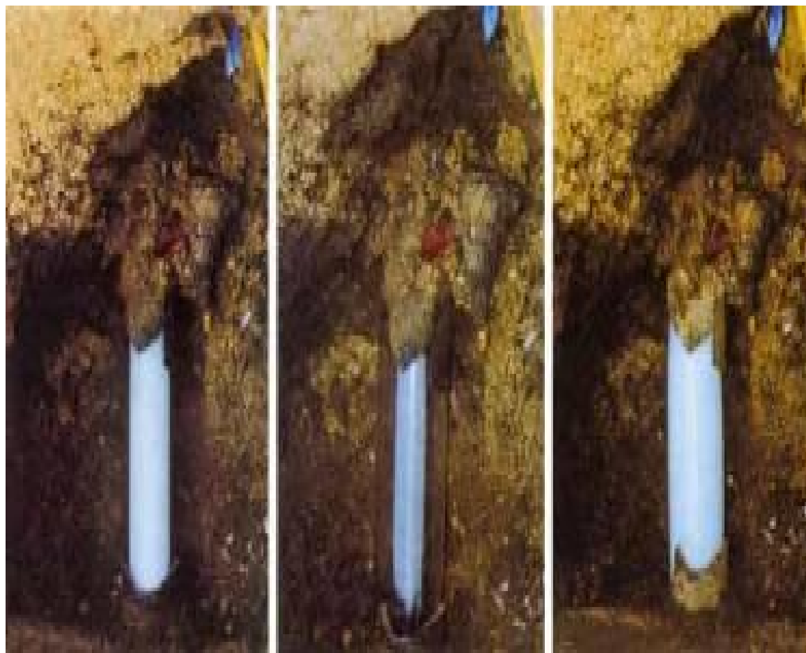
Εικόνα 6 : (α) Η επένδυση στη μειωμένη διάμετρο αμέσως μετά την εισαγωγή. (β) Η επένδυση σε άμορφη κατάσταση, ενώ έχει ενεργοποιηθεί το υλικό με μνήμη σχήματος. (γ) Μετά την ψύξη και κρυστάλλωση, επιτυγχάνουμε τη πλησιέστερη στην αρχική μορφή του σωλήνα .
