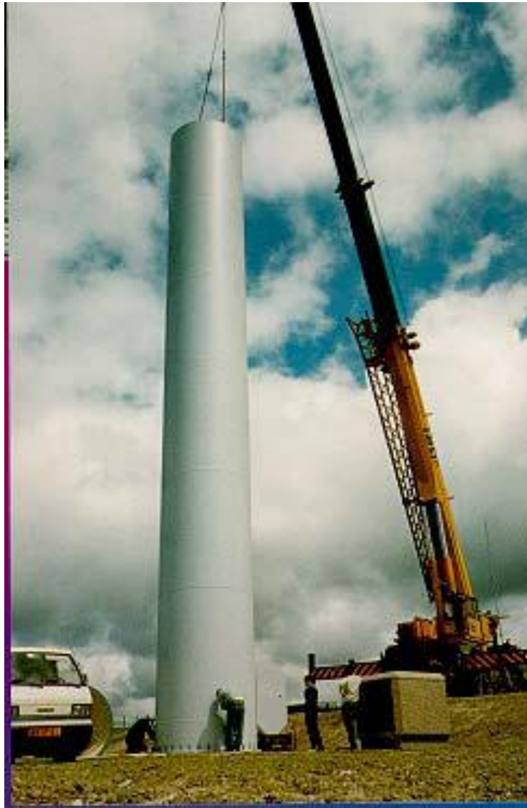
Σχήμα 2-9: Συναρμολόγηση χαλύβδινων πύργων.
