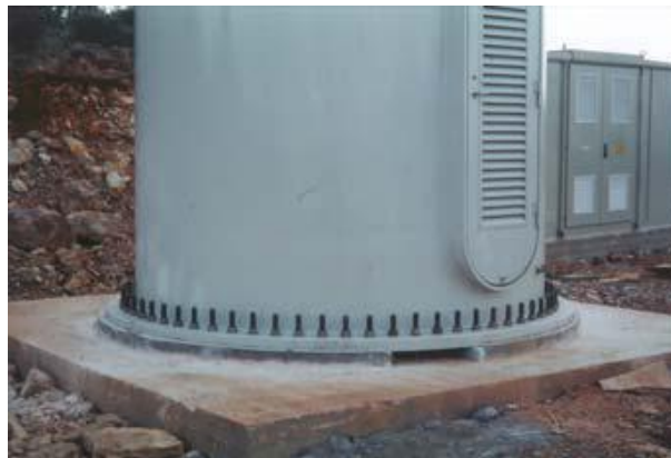
Σχήμα 2-10: Θεμελίωση χαλύβδινων πύργων.
