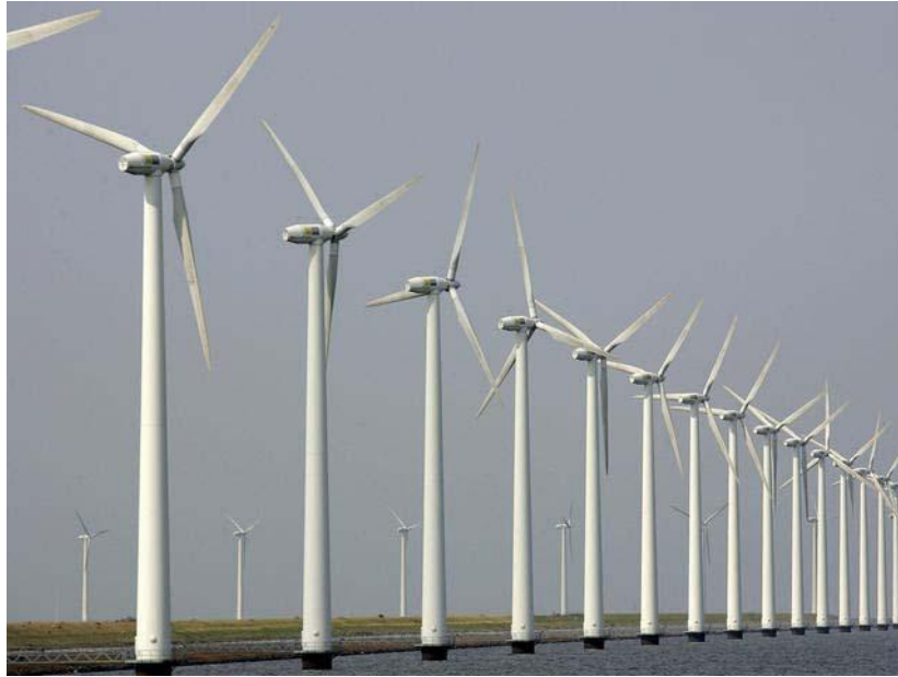
Σχήμα 2-7: Ανεμογεννήτριες με χαλύβδινους σωληνοειδείς πύργους.
