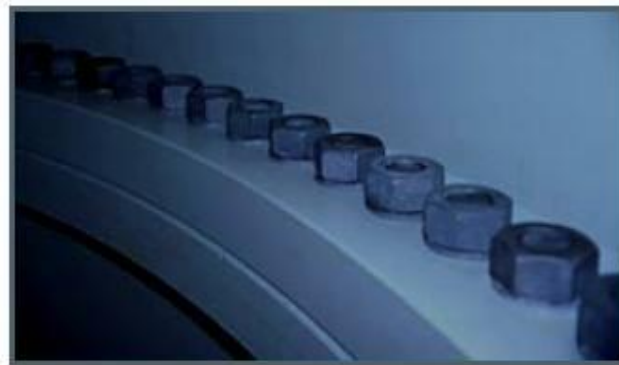
Σχήμα 2-8: Εσωτερική σύνδεση κομματιών σωληνωτού πύργου.
