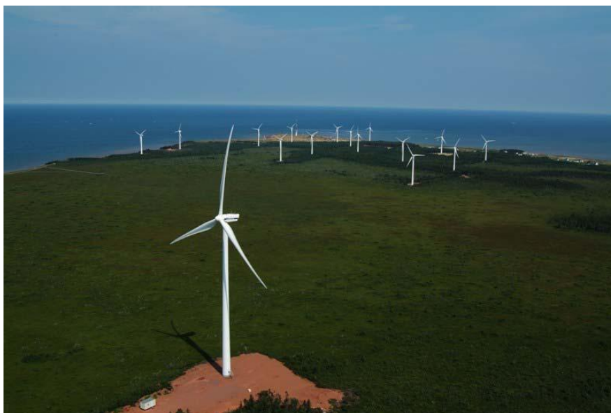
Σχήμα 2-15: Αιολικό Πάρκο κοντά στην ακτή.
