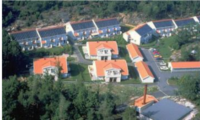
Σχήμα 1-5: Φωτοβολταϊκά σε κατοικίες.
