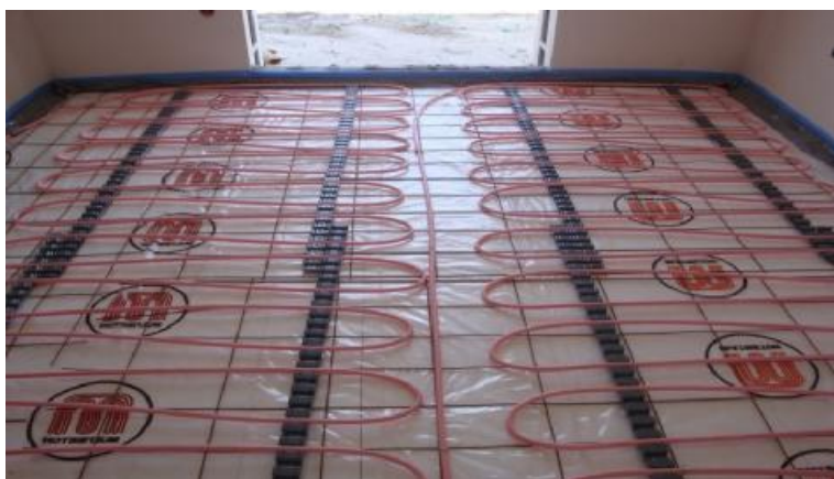
Σχ 2.13 : Στήριξη σωλήνα θέρμανσης δαπέδου
