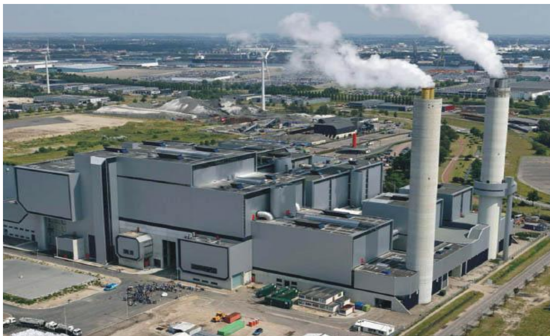
Εικόνα 5:Εργοστάσιο θερμικής επεξεργασίας
