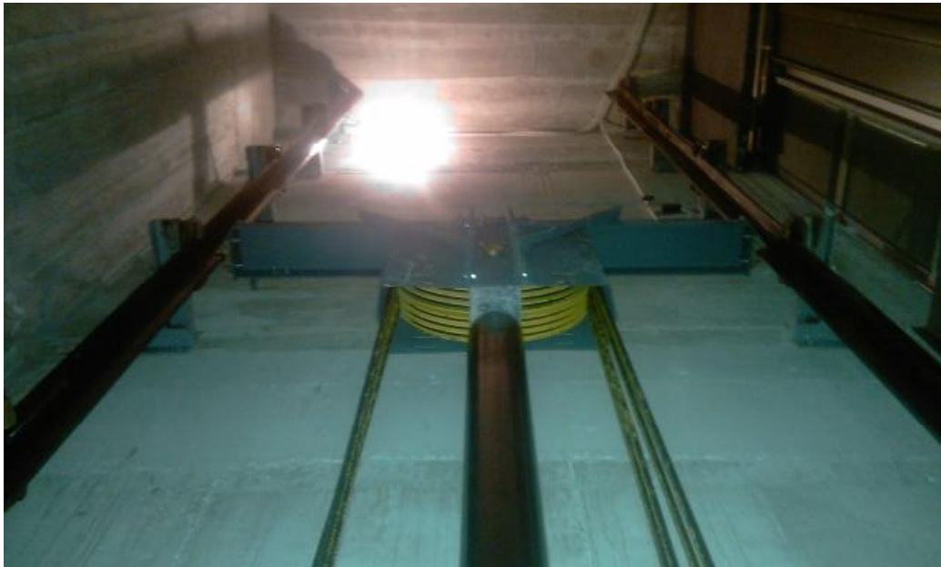
Εικόνα 4.5.: Τροχαλία υδραυλικού ανελκυστήρα.
