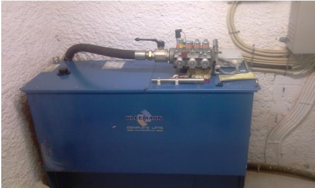
Εικόνα 4.7.: Μονάδα ισχύος και υδραυλική βαλβίδα υδραυλικού ανελκυστήρα.
