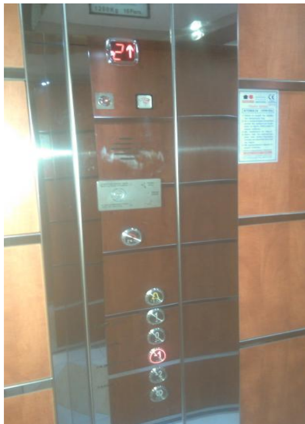
Εικόνα 4.8.: Κομβιοδότης θαλάμου υδραυλικού ανελκυστήρα.
