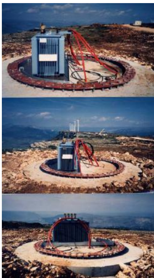
Σχήμα 4.2: Καλώδια που θα εισέρχονται και θα εξέρχονται από την βάση του πυλώνα της ανεμογεννήτριας
