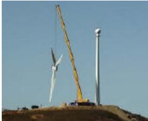
Σχήμα 4.6: Ανύψωση πλήμνης
