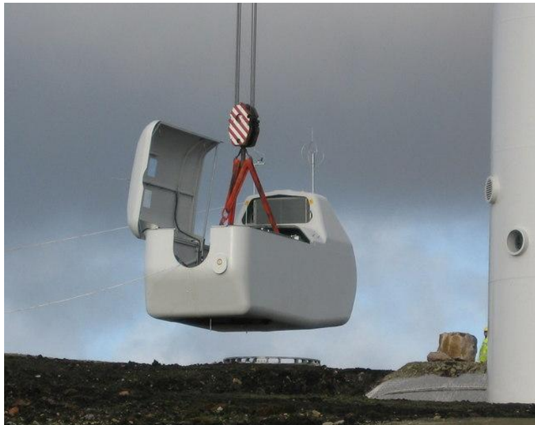
Σχήμα 1.27: Νασέλλα-Ατρακτίδιο
