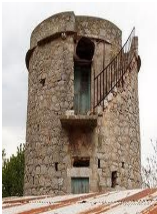
Σχήμα 1.15: Ανεμόμυλος με κατακόρυφο άξονα εγκατεστημένο στην Κρήτη
