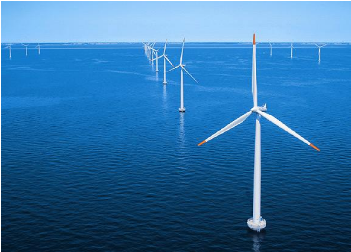
Σχήμα 1.12: Υπεράκτιο αιολικό πάρκο
