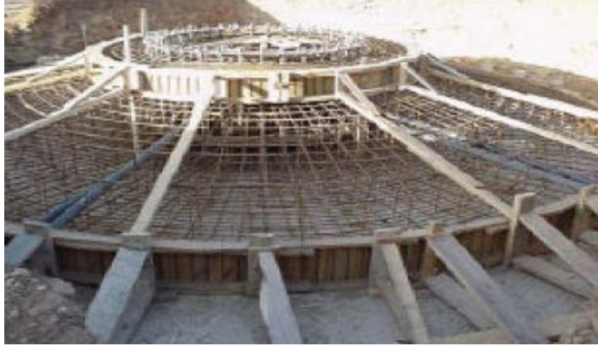
Σχήμα 4.3: Κατασκευή θεμελίων
