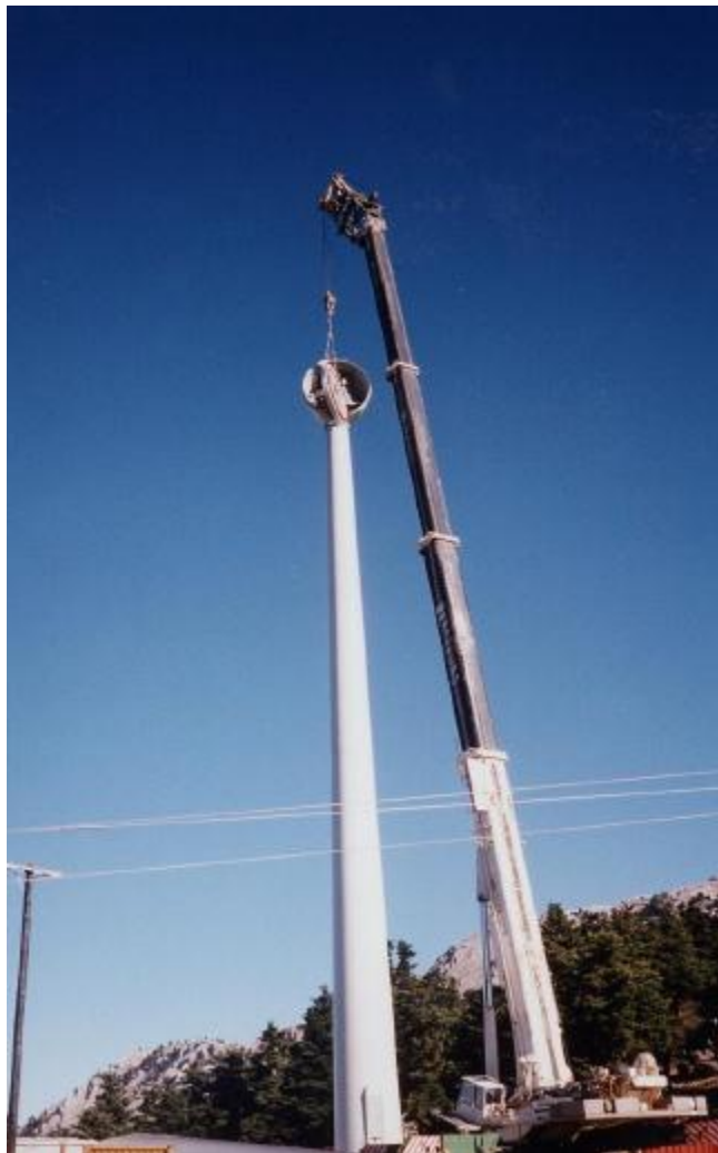
Σχήμα 4.5: Ανύψωση ατράκτου
