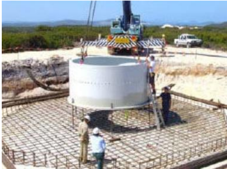
Σχήμα 4.4: Τοποθέτηση κεντρικής βάσης
