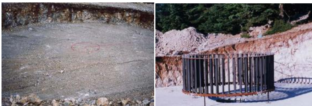
Σχήμα 4.1: Βάση θεμελίωσης σκυροδέματος μετά του απαραίτητου σιδηρού οπλισμού
