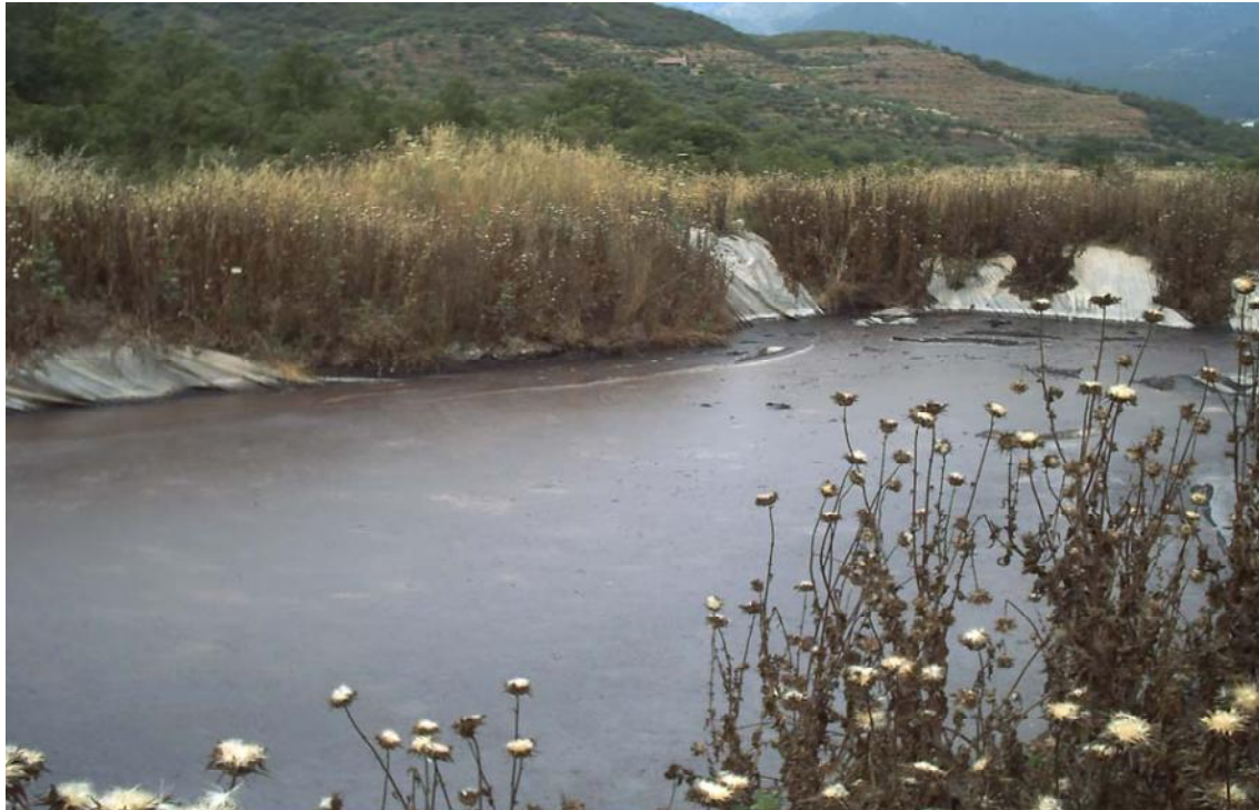
Εικόνα 4.5: Διάθεση των ανεπεξεργαστων υγρών αποβλήτων ελαιοτριβείων σε τεχνητή λίμνη εξάτμισης.
