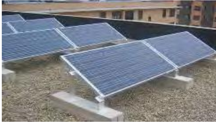
Εικόνα 6.2: Τοποθέτηση πλαισίων σε μεταλλική κατασκευή
