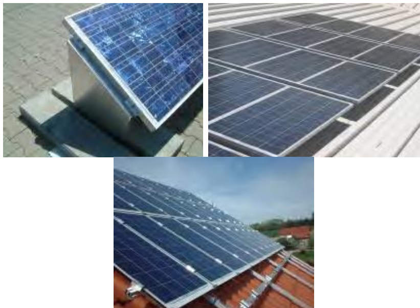
Εικόνα 5.5: Βάσεις στηριξης για φωτοβολταικά σε στέγες
