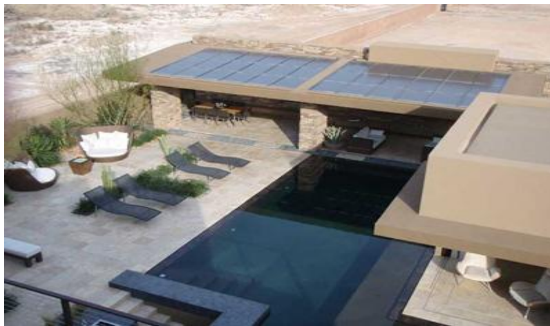
Εικόνα 6.3: Τοποθέτηση πλαισίων σε δώμα
