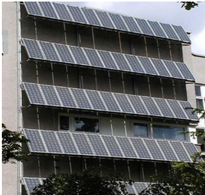
Εικόνα 6.4: Εγκατάσταση φωτοβολταϊκών σε πολυκατοικία
