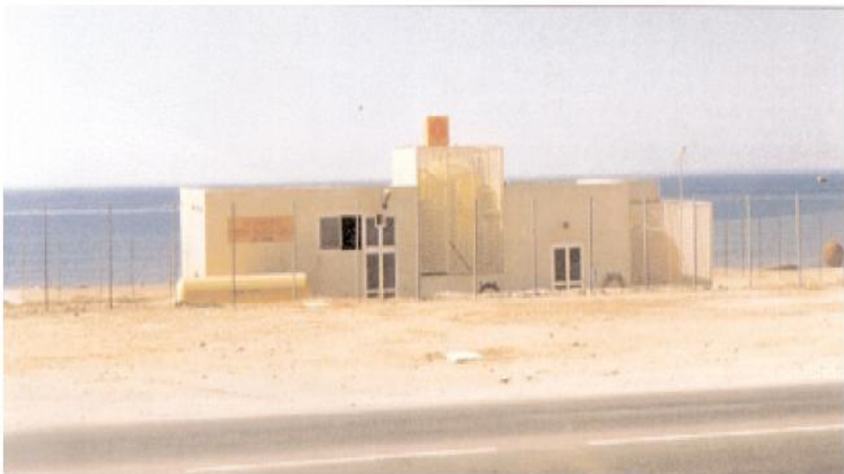
Αντλιοστάσιο θαλάσσιου νερού
