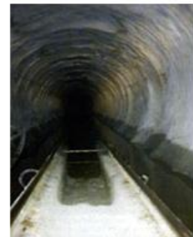
Σήραγγα εκτροπής Διάριζου
