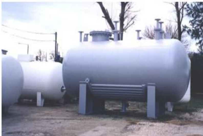
Σχήμα 3.11: Δοχείο πίεσεως με τα βασικά του μέρη.
