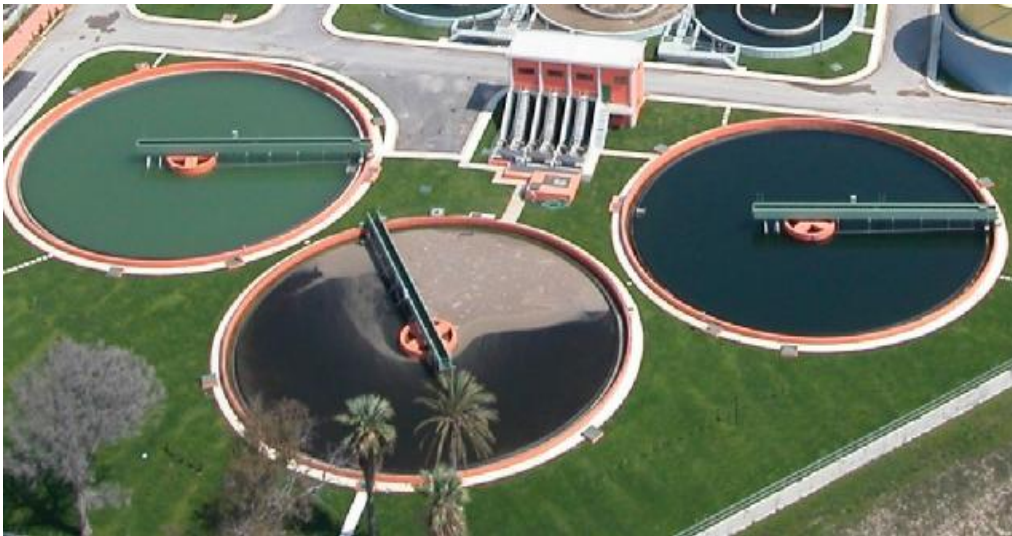
Εικόνα 31 : Δεξαμενές τελικής καθίζησης
