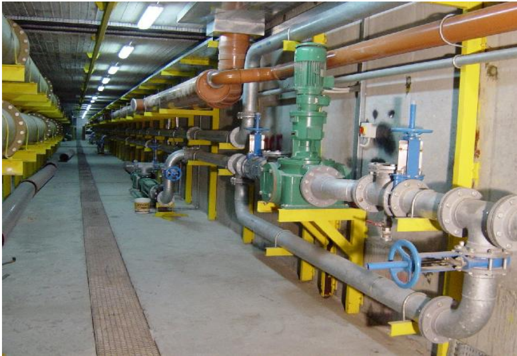
Εικόνα 30 : Μονάδα βιολογικής επεξεργασίας
