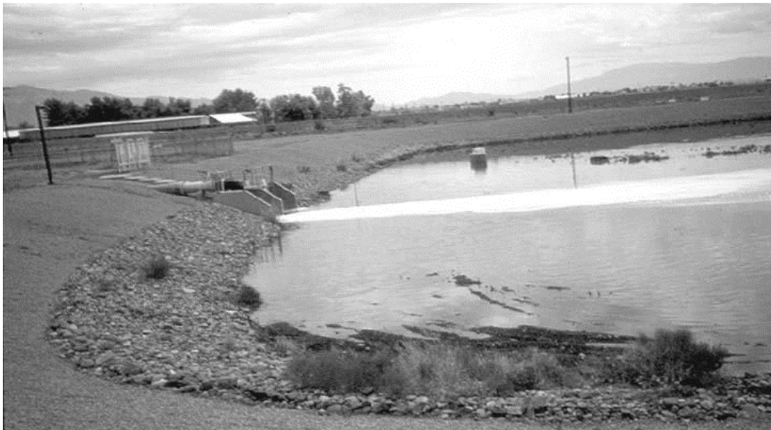
Εικόνα 15.2. Λεκάνη ταχείας διήθησης στο Phoenix της Αριζόνα
