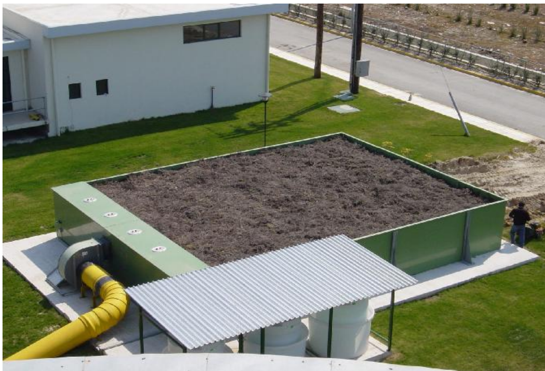
Εικόνα 34 : Σύστημα απόσμησης
