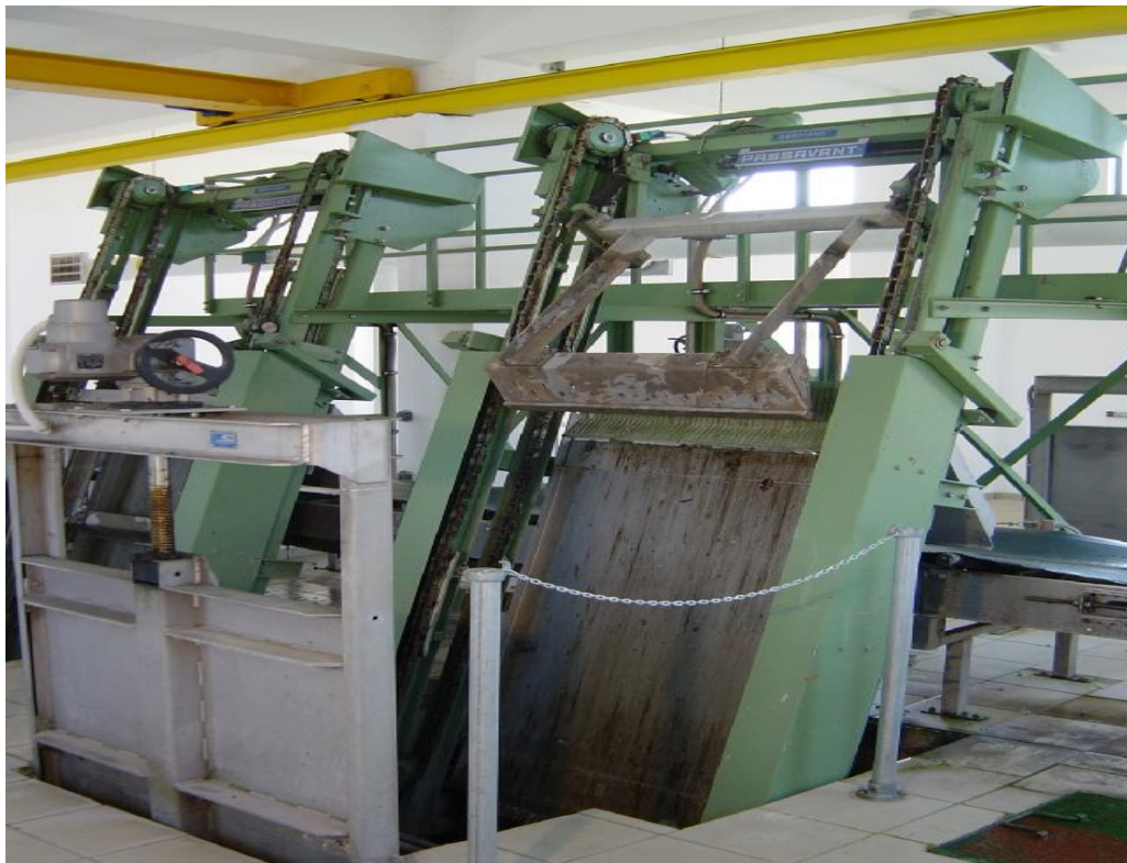
Εικόνα 27 : Αυτοκαθαριζόμενες λεπτές σχάρες
