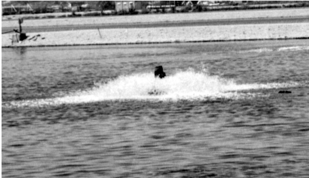
Εικόνα 9. Επιπλέοντας αεριστήρας αεριζόμενης λίμνης
