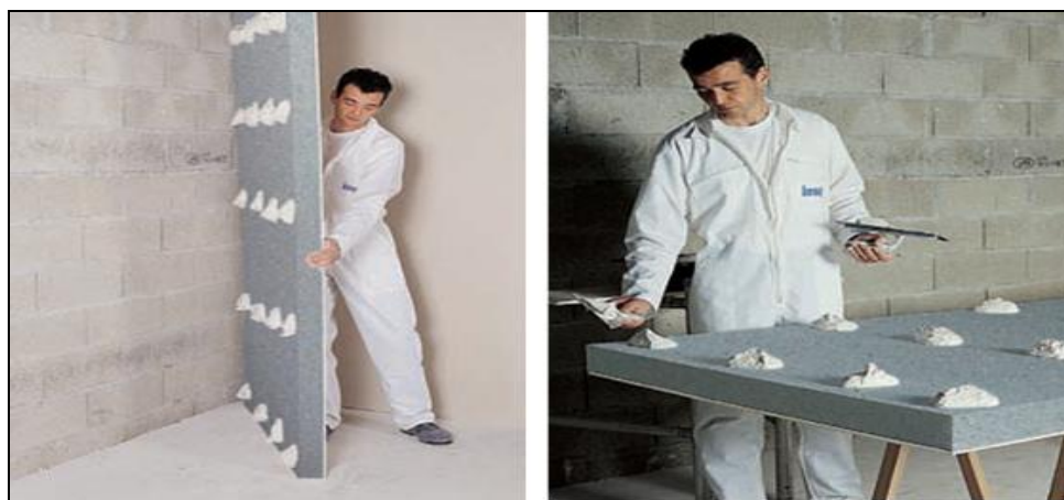
Εικόνα 3.5: Εσωτερική θερμομόνωση κτιρίου Πηγή : KNAUF
