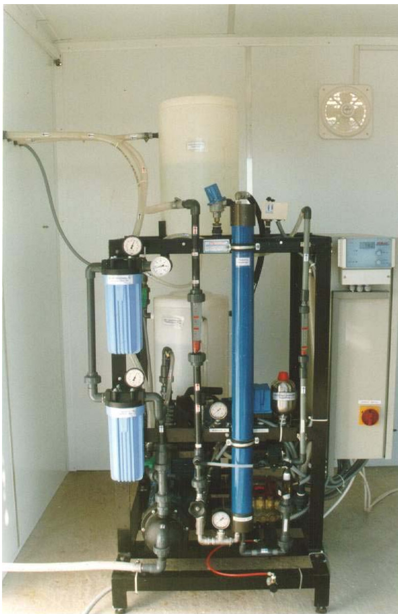
Εικόνα 4.3 Μονάδα Αντίστροφης Οσμωσης Θαλασσινού Νερού, 1.5 m 3 /ημέρα, Κέντρο Ανανεώσιμων Πηγών Ενέργειας.
