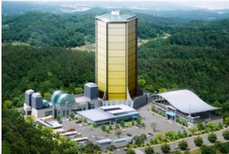
Εικόνα 6.4 Ο αιολικός πύργος της ZENA Systems στην Ιαπωνία.
