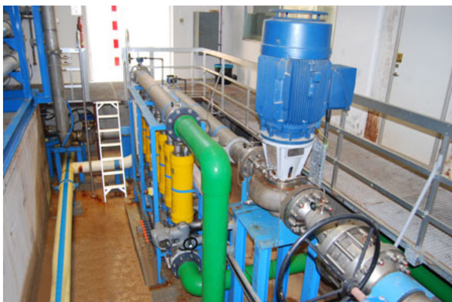
Εικόνα 4.4 Συσκευές ανάκτησης ενέργειας τύπου «Pressure Exchange» στη μονάδα αφαλάτωσης στη Δεκέλεια της Κύπρου.
