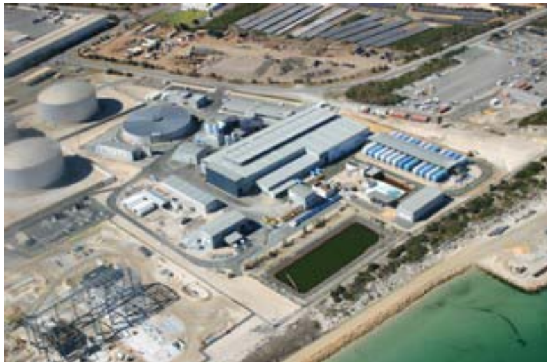
Εικόνα 9.3 Εργοστάσιο αφαλάτωσης στο Περθ της Δυτικής Αυστραλίας.
