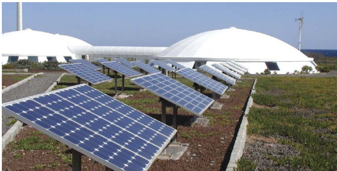
Εικόνα 6.1 Αυτόνομη μονάδα αφαλάτωσης αντίστροφης ώσμωσης τροφοδοτούμενη με φωτοβολταϊκά στοιχεία στα Κανάρια Νησιά.
