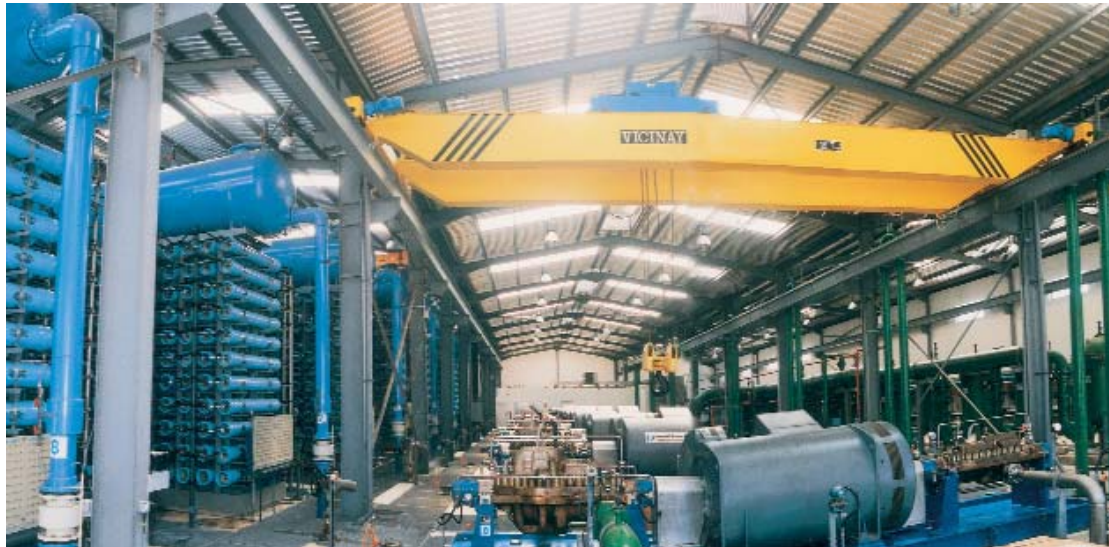
Εικόνα 9.6 Η μονάδα αφαλάτωσης με αντίστροφη ώσμωση στη Λάρνακα.
