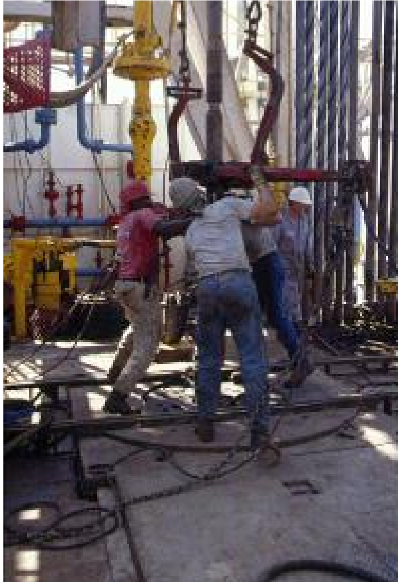
Εικόνα 11.5.2.1 Εργασίες τοποθέτησης περιστρεφόμενου σωλήνα-δραπάνου
