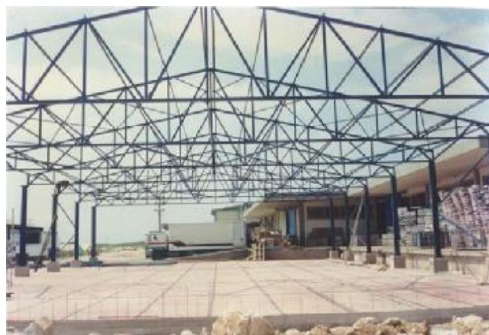
Σχήμα 3.3: Μεταλλική Στέγη Διαστάσεων 12.48 m x 22.58 m. Ύψους Ζευκτού 6.50 m. [6]
