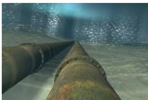
ΕΙΚΟΝΑ 11.2 ( ΥΠΟΘΑΛΑΣΣΙΟΣ ΑΓΩΓΟΣ ΜΕΤΑΦΟΡΑΣ ΠΕΤΡΕΛΑΙΟΥ) [60]
