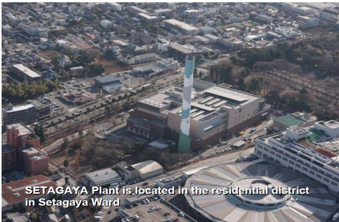
Σχήμα 2.2 Σταθμός επεξεργασίας Α.Σ.Α. εντός αστικής περιοχής
