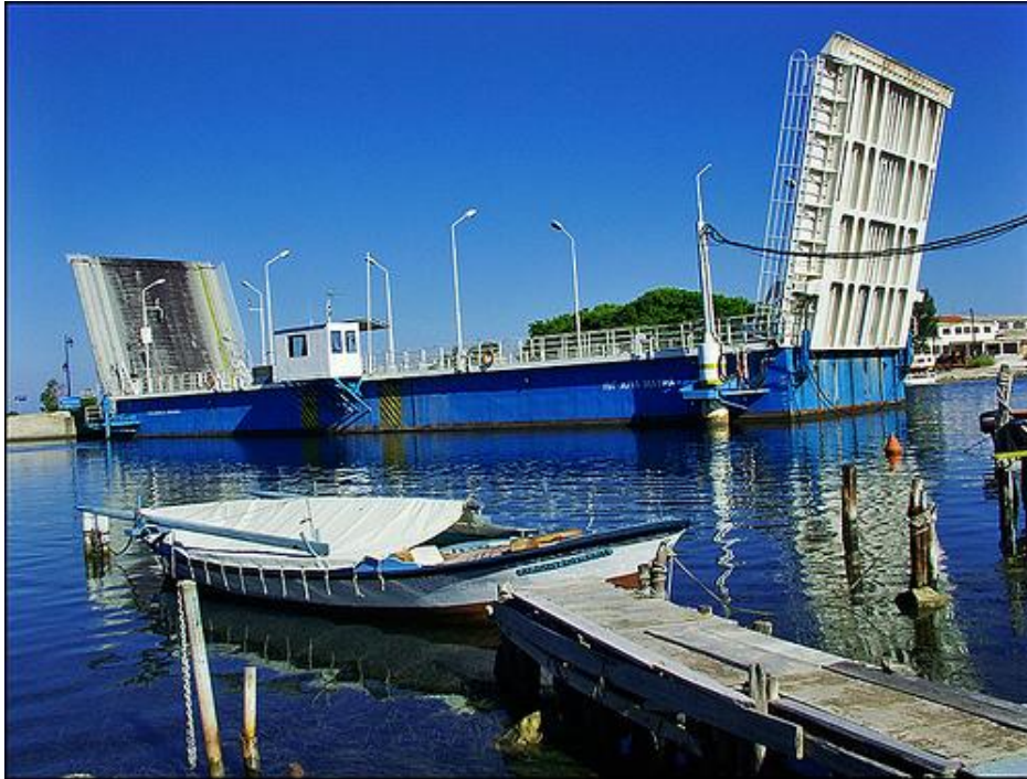
Σχήμα 11: Η γέφυρα που ενώνει το νησί της Λευκάδας με την ηπειρωτική Ελλάδα. (πηγή: www.google.gr )
