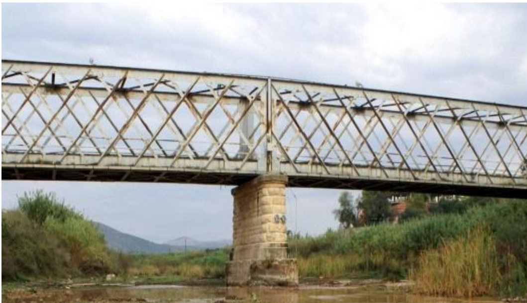
Γέφυρα Ευρώτα στην περιοχή της Σκάλας
