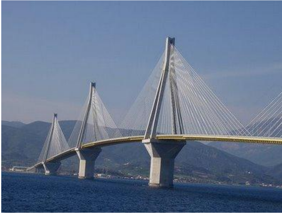
Σχήμα 8: Φωτογραφία της γέφυρας Ρίου Αντιρρίου. (πηγή: www.google.gr )
