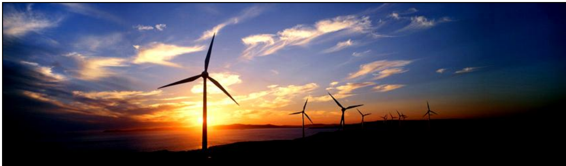
Σχήμα 2.6: Αιολικό πάρκο παραγωγής ηλεκτρικής ενέργειας.
