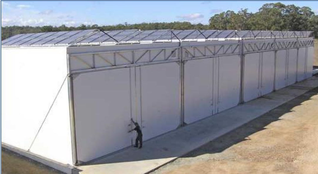
Σχήμα 3.8: Ηλιακό ξηραντήριο τύπου δωματίου με συλλέκτες νερού.
