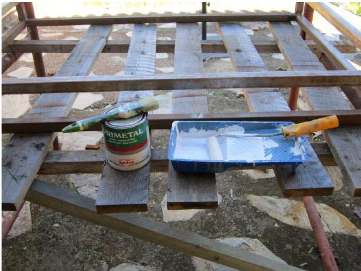
Εικόνες 6.22 και 6.23: Προετοιμασία πλαισίου για βαφή
