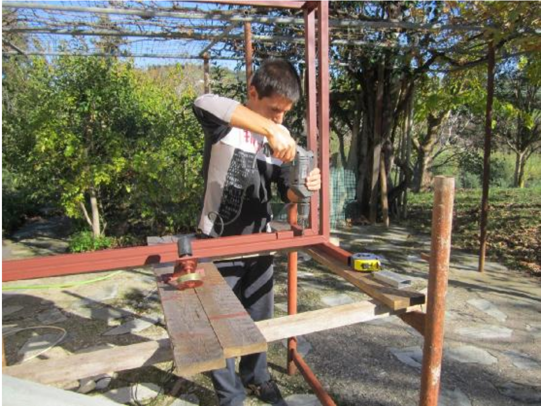
Εικόνα 6.44: Άνοιγμα οπής στο πλαίσιο
