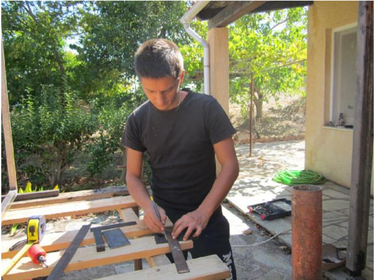
Εικόνα 6.29: Προετοιμασία για άνοιγμα οπών στις μεταλλικές πλάκες
