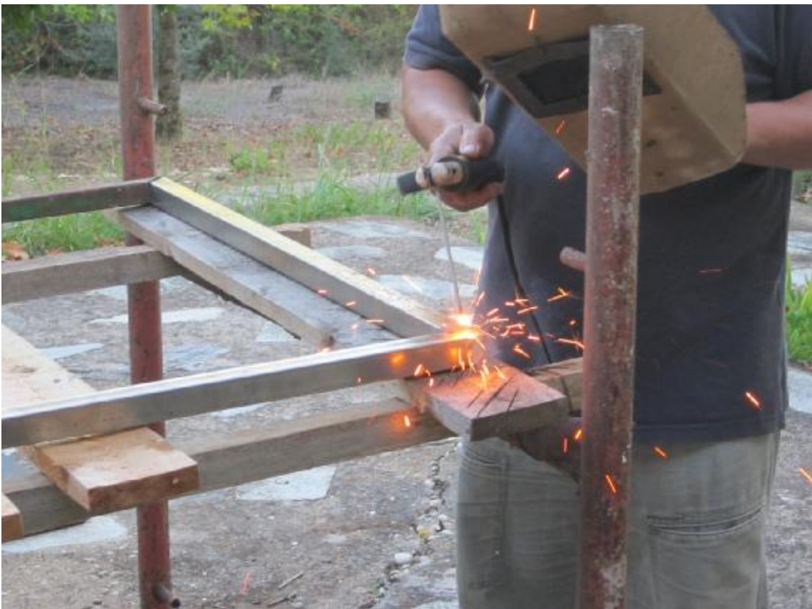
Εικόνες 6.8 και 6.9: Ηλεκτροσυγκόλληση κοιλοδοκών
