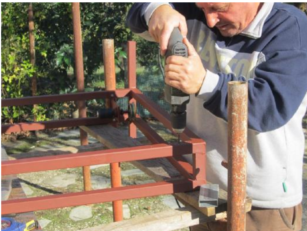
Εικόνα 6.47: Άνοιγμα οπής
