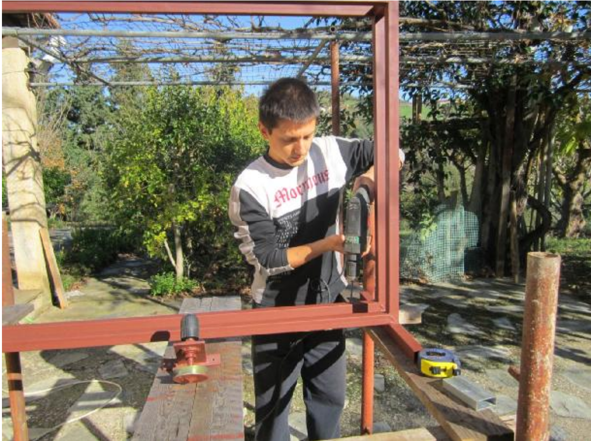
Εικόνα 6.43: Άνοιγμα οπής στο πλαίσιο
