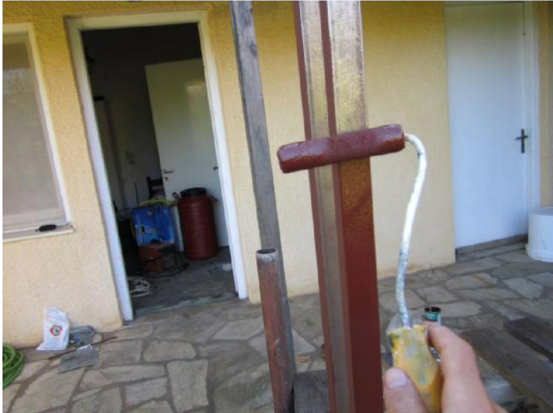
Εικόνα 6.26: Βαφή πλαισίου με προστατευτικό χρώμα
