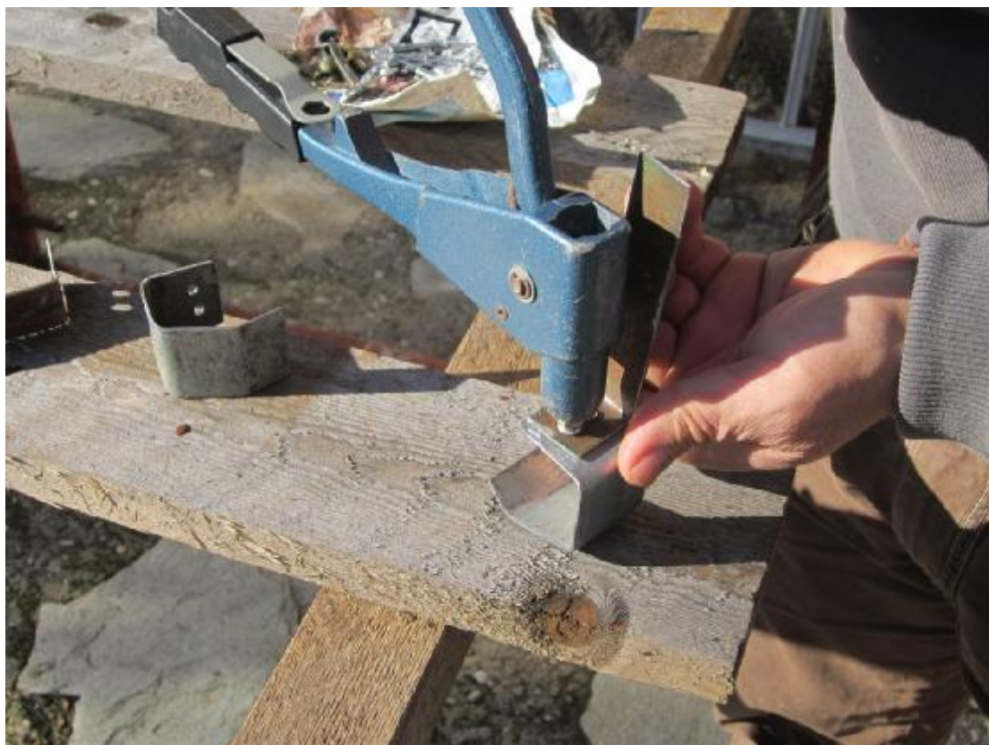
Εικόνα 6.51: Κατασκευή στηρίξεων για τα μοιρογνωμόνια
