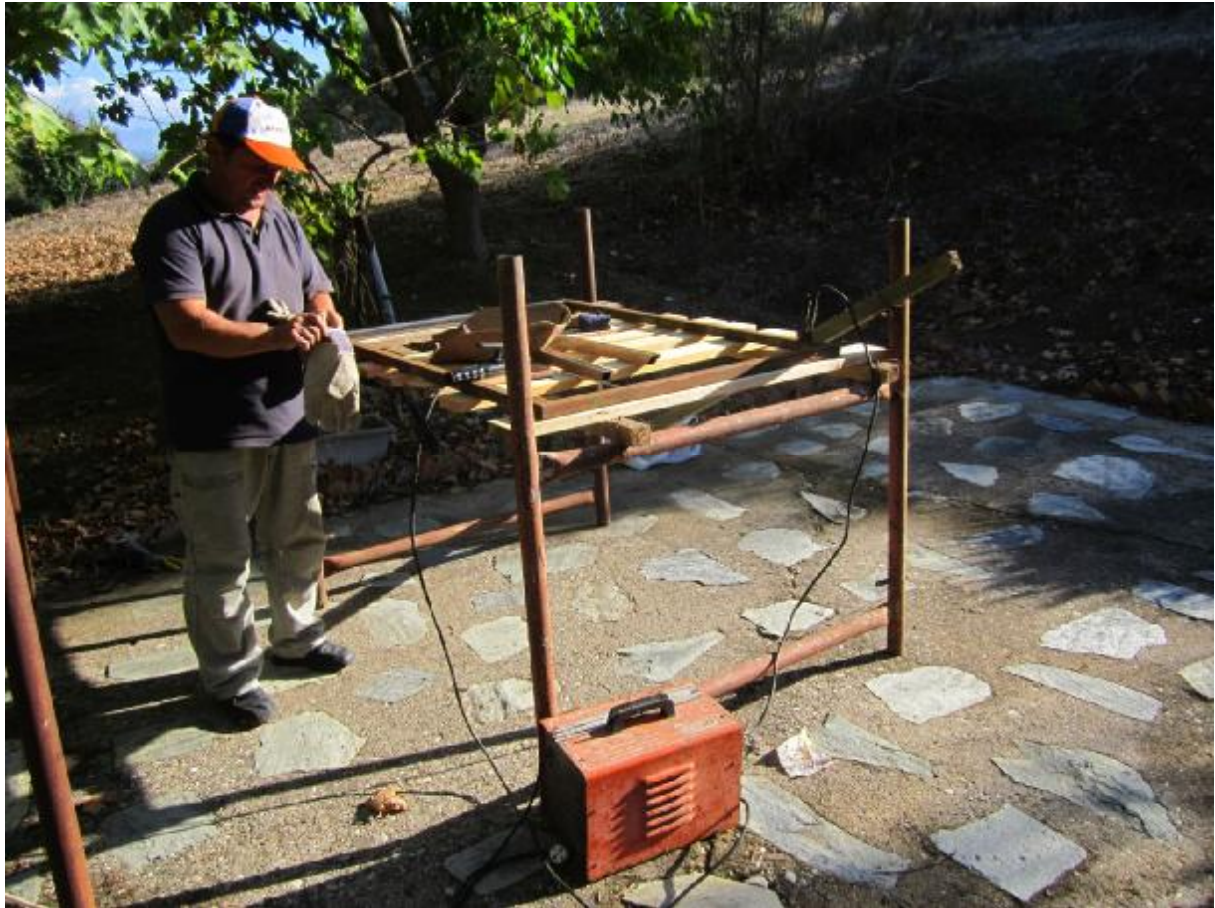
Εικόνα 6.5: Προετοιμασία για ηλεκτροσυγκόλληση
