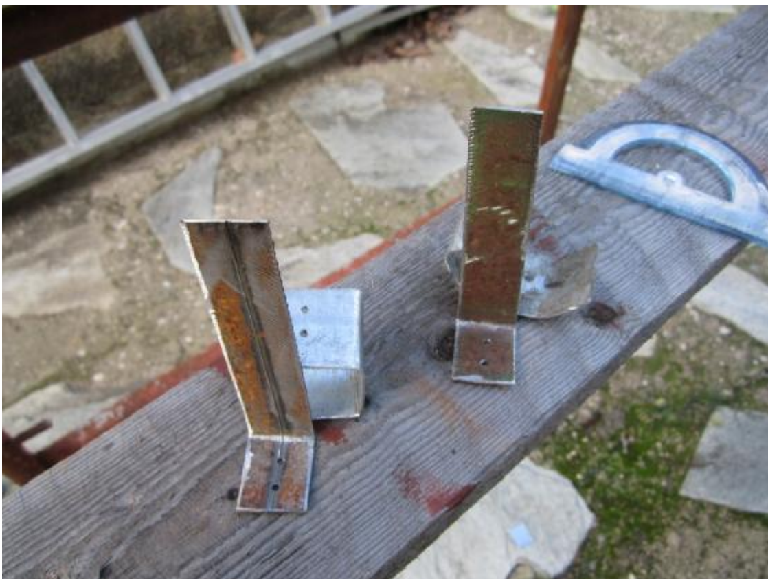
Εικόνες 6.49 και 6.50: Κατασκευή στηρίξεων για τα μοιρογνωμόνια
