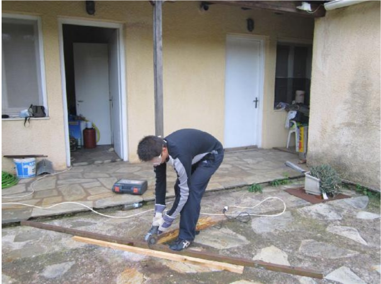
Εικόνα 6.3: Κοπή κοιλοδοκών
