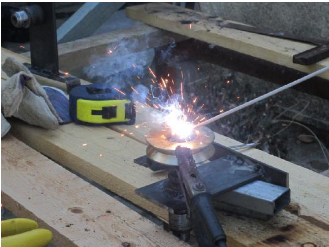
Εικόνες 6.40 και 6.41: Ηλεκτροσυγκόλληση τροχαλίας στον άξονα
