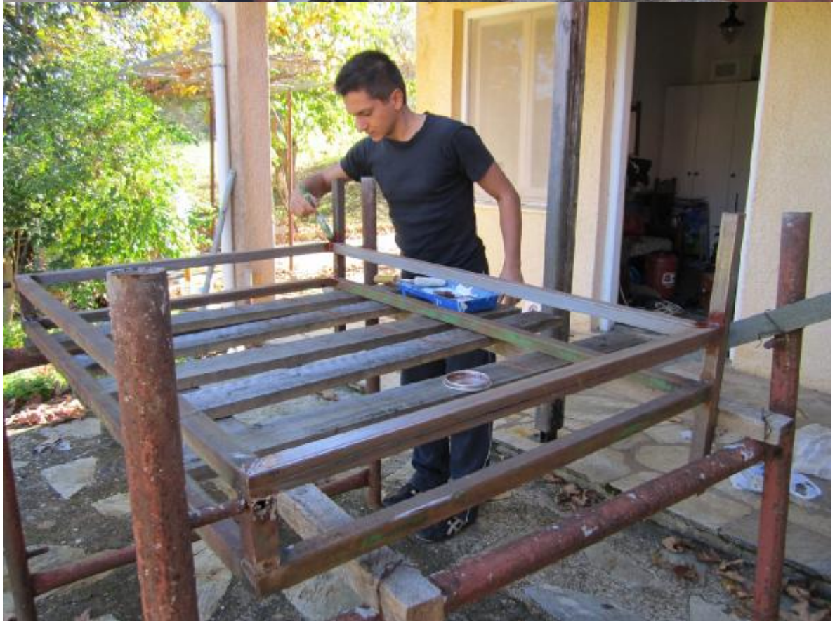
Εικόνες 6.24 και 6.25: Βαφή πλαισίου με προστατευτικό χρώμα
