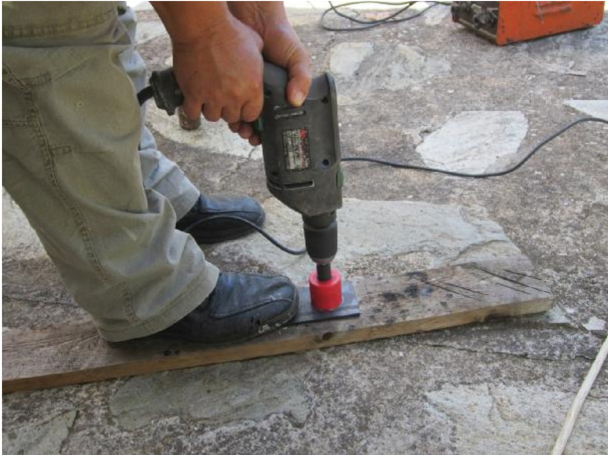
Εικόνα 6.30: Άνοιγμα οπής
