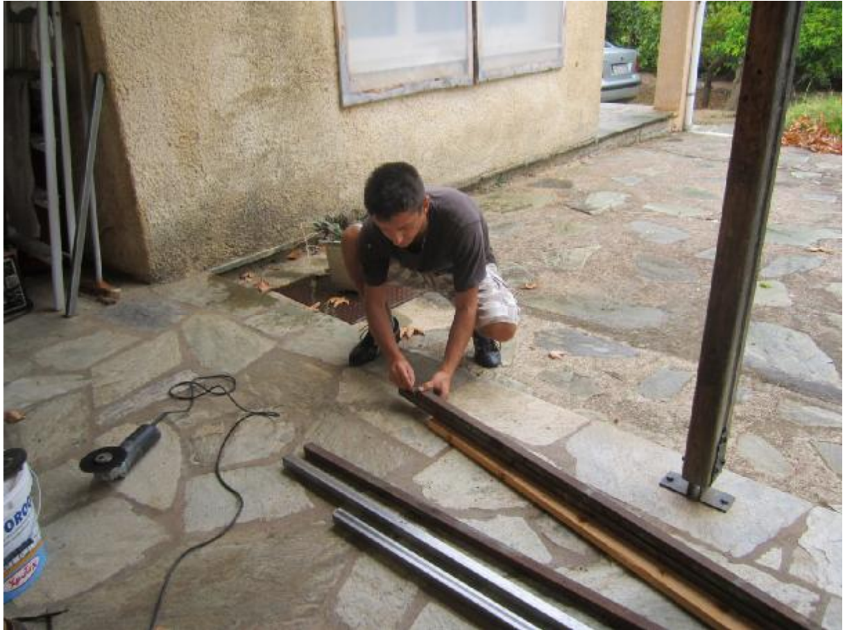
Εικόνα 6.2: Προετοιμασία κοιλοδοκών για κοπή
