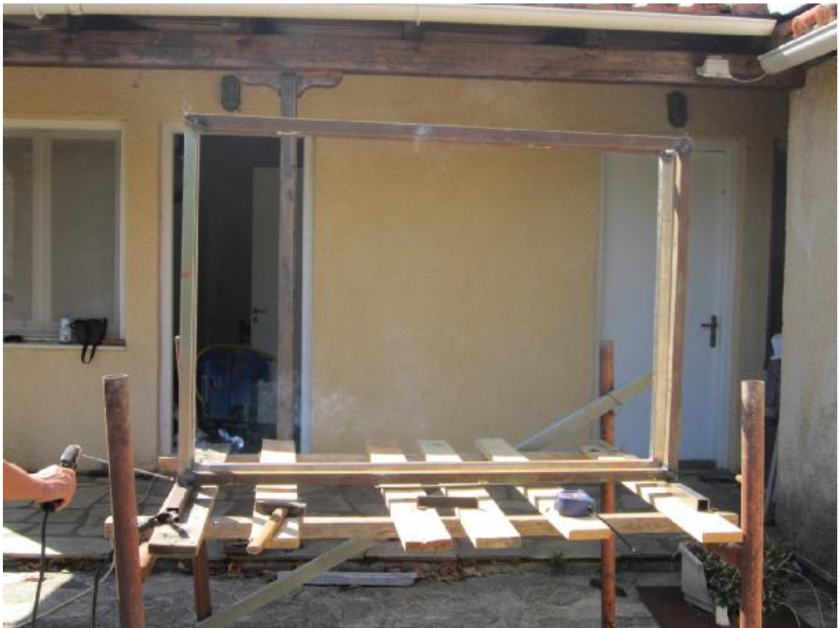
Εικόνες 6.19 και 6.20: Συγκόλληση πλαισίου με τις δύο βάσεις
