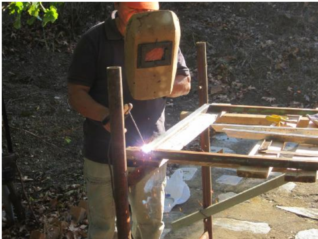
Εικόνες 6.6 και 6.7: Ηλεκτροσυγκόλληση κοιλοδοκών
