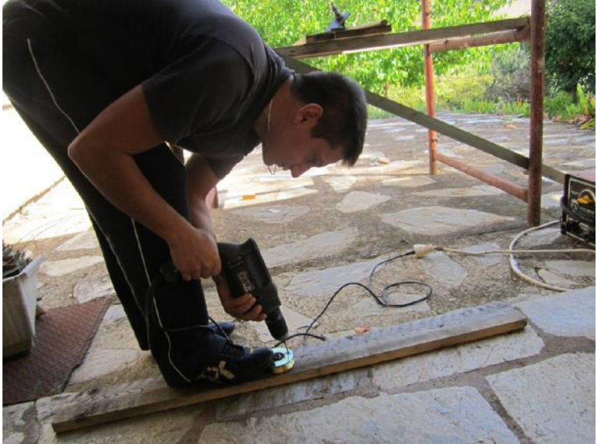
Εικόνα 6.37: Άνοιγμα οπής για το συρματόσχοινο
