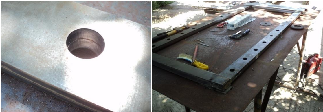
Εικόνα 122: Μοντάρισμα και συγκόλληση δεύτερου τμήματος πλαισίου πρέσας.
