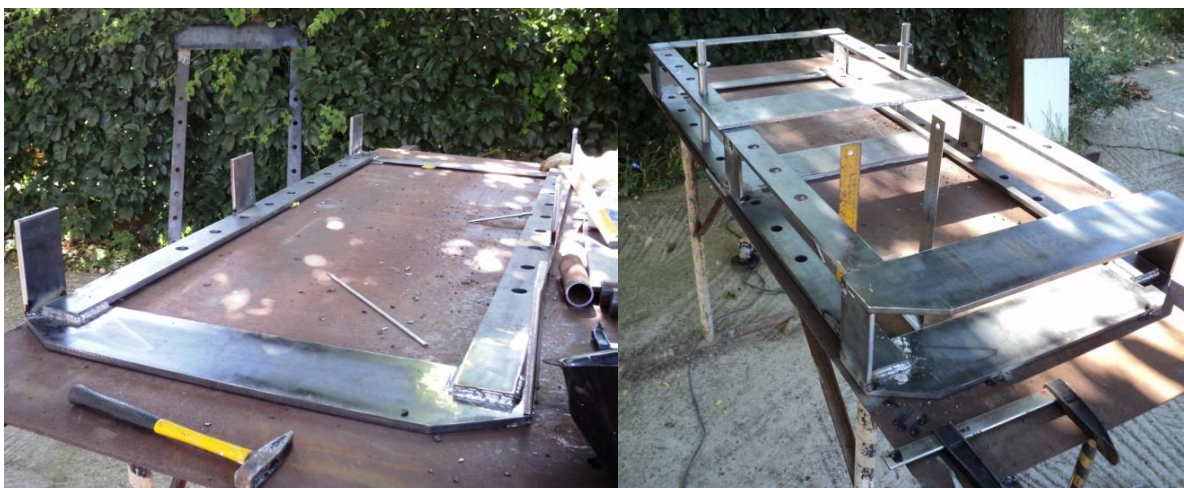
Εικόνα 123: Τοποθέτηση αποστατών πλαισίου και μοντάρισμα του πρώτου τμήματος με το δεύτερο.
