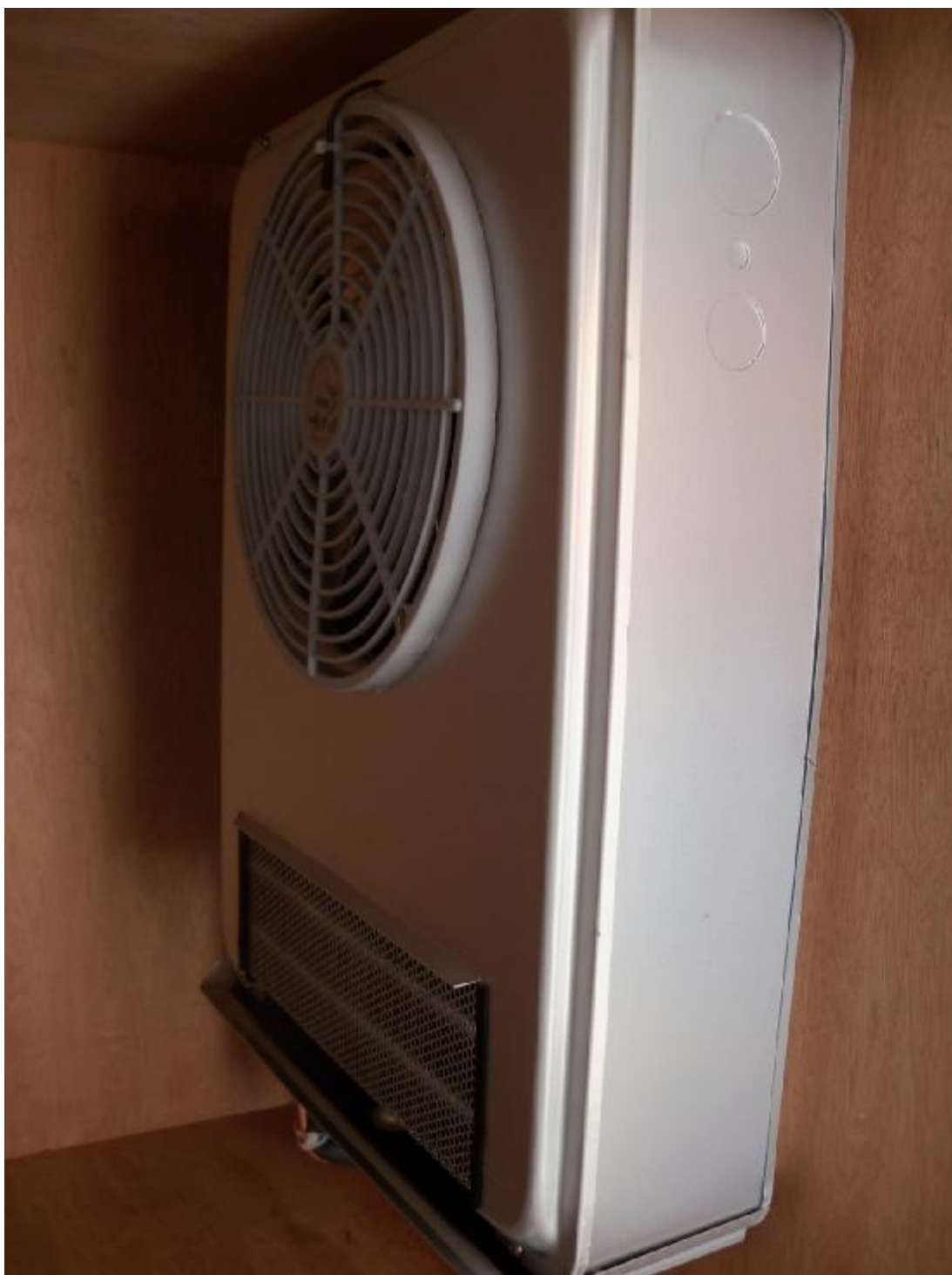
Εικόνα 2.4: Στοιχείο πλάτης PL13, δηλαδή ο εξατμιστής που βρίσκεται μέσα στο κουτί.
