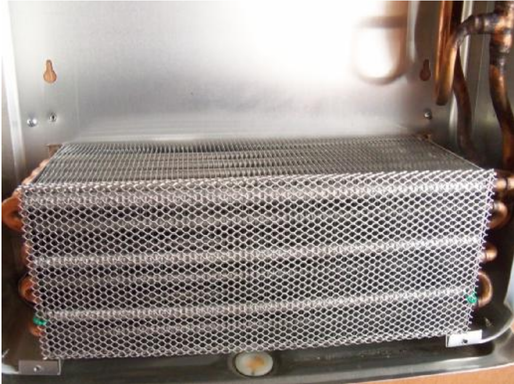
Εικόνα 2.5: Εδώ διακρίνεται ο εναλλάκτης του εσωτερικού στοιχείου.
