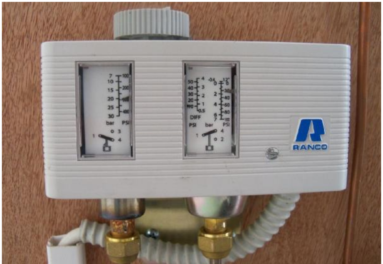
Εικόνα 2.14: Πρεσσοστάτης Ranco υψηλής-χαμηλής πίεσης, ο οποίος καθορίζει το εύρος των πιέσεων μέσα στο οποίο πρέπει να λειτουργεί η διάταξη συνδεόμενος με τον τερματικό διακόπτη, μπορεί να σταματήσει την λειτουργία της διάταξης σε περίπτωση μεγάλης αύξησης ή μεγάλης πτώσης της πίεσης.
