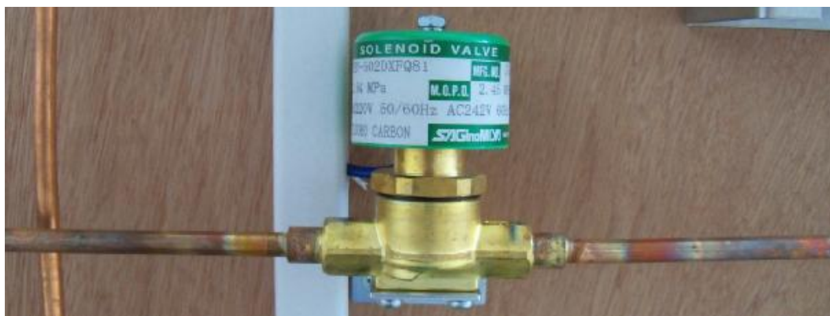
Εικόνα 2.16: Ηλεκτρομαγνητικές βαλβίδες SAGINOMIYA 1/4 κολλητή, που εξυπηρετούν στην αντιστροφή από ψύξη σε θέρμανση και το ανάποδο.
