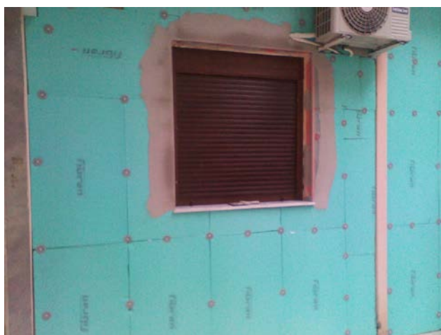
Εικόνα 3.2. Εξωτερική θερμομόνωση
