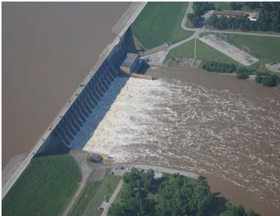
Εικόνα 2.3 Φράγμα από σκυρόδεμα
