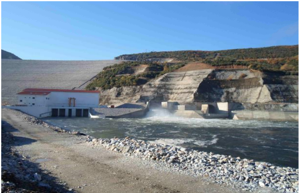
Εικόνα 6.1 Υδροηλεκτρικός σταθμός Ιλαρίωνα
