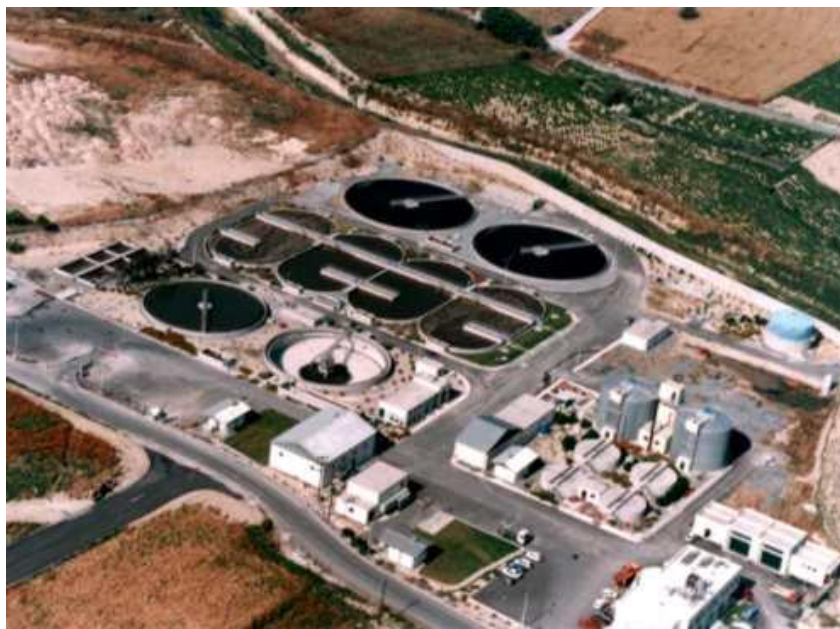
Εικόνα 3.1: Τυπική διάταξη βιολογικού καθαρισμού (zwpallini.gr)
