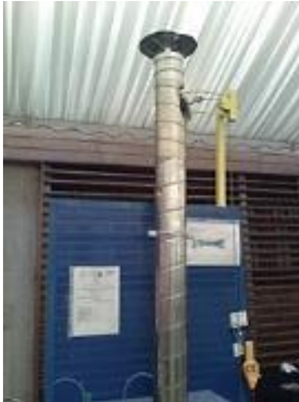
Εικόνα 2.10: Καπνοδόχος λέβητα, αυτοκαθαριζόμενη.
