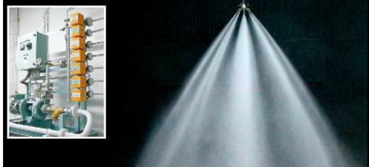
Εικόνα 3.10: Αυτόματο σύστημα τεχνητής ομίχλης νερού.
