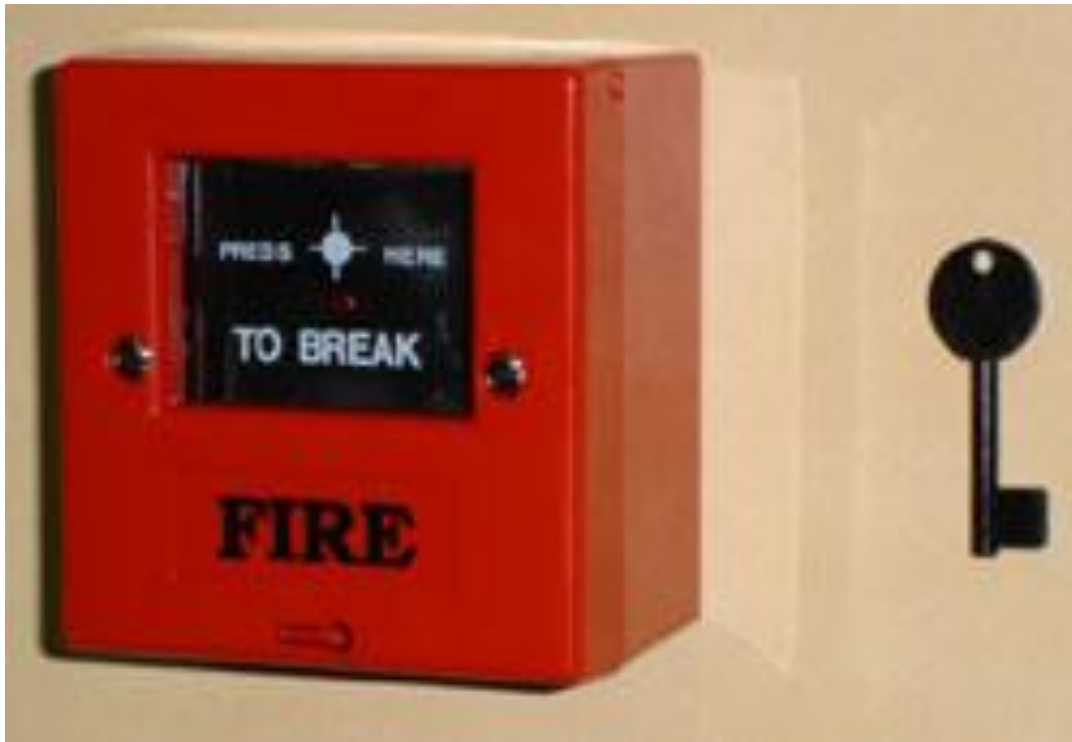
Εικόνα 3.14: Χειροκίνητο σύστημα συναγερμού.
