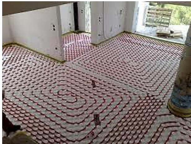
Εικόνα 1.2: Ενδοδαπέδιο σύστημα θέρμανσης.
