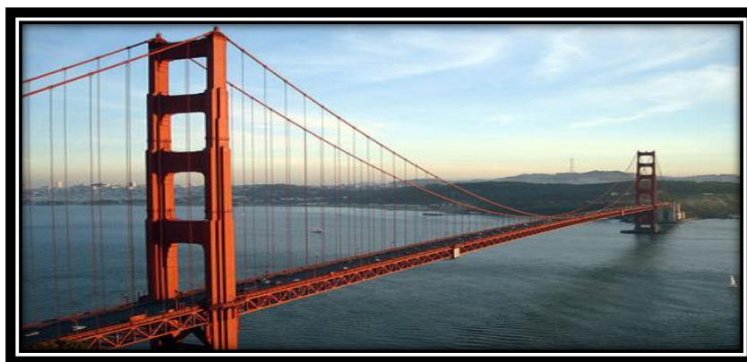
Εικόνα 2.4: Γέφυρα Golden Gate (ΗΠΑ) (wikipedia)
