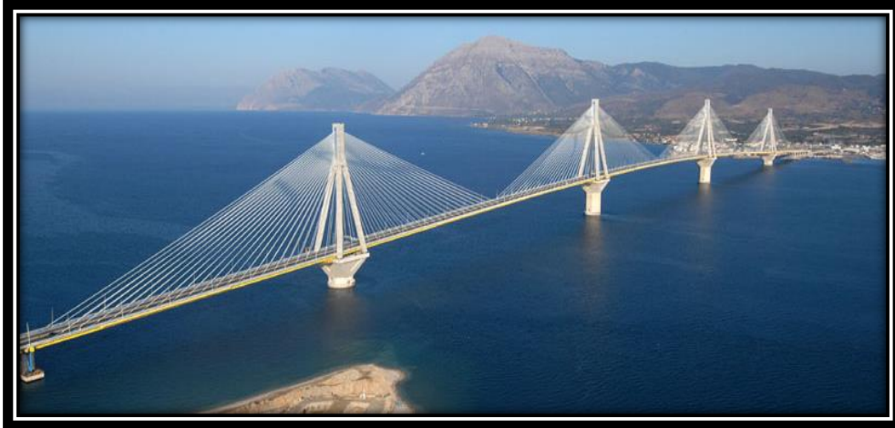
Εικόνα 2.5: Γέφυρα Ρίου-Αντιρρίου (Ελλάδα) (wikipedia)
