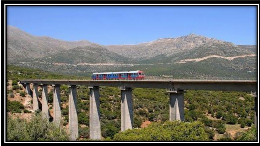
Εικόνα 3.10: Γέφυρα Αχλαδόκαμπου ( www.panoramio.com )
