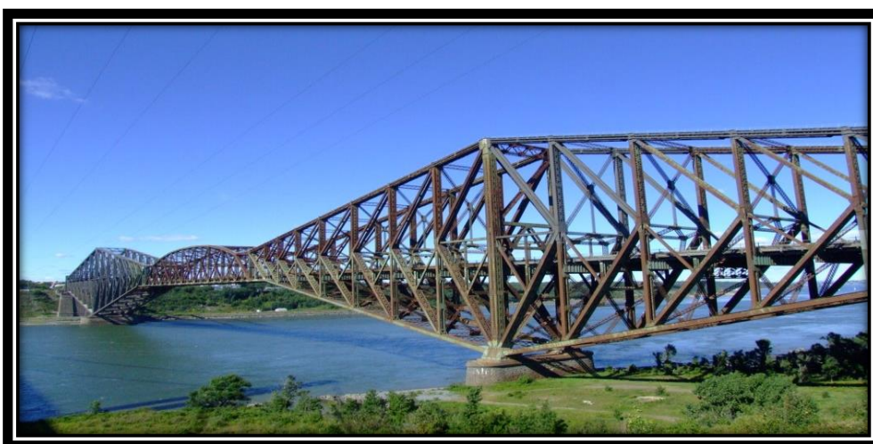
Εικόνα 1.5: Quebec Bridge (Καναδάς) (wikipedia)
