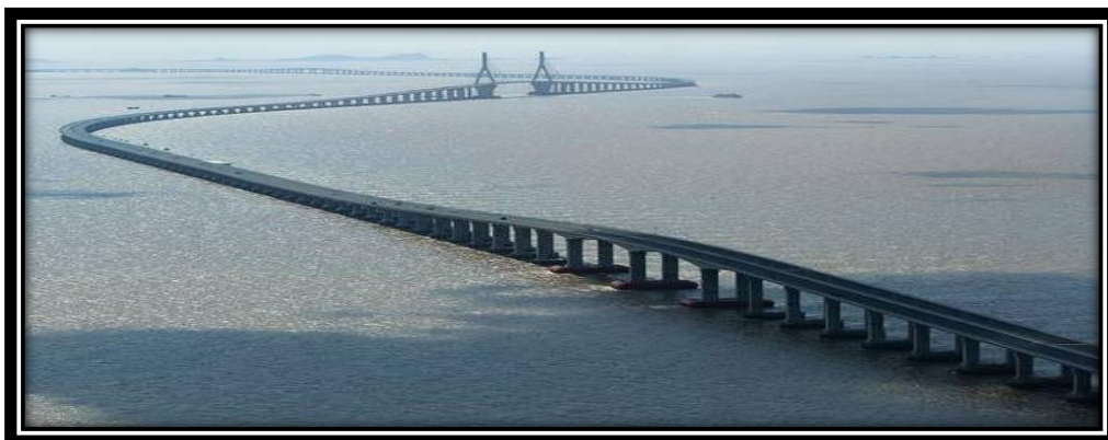
Εικόνα 2.10: Γέφυρα Danyang–Kunshan (Κίνα) (www.glamgrid.com)
