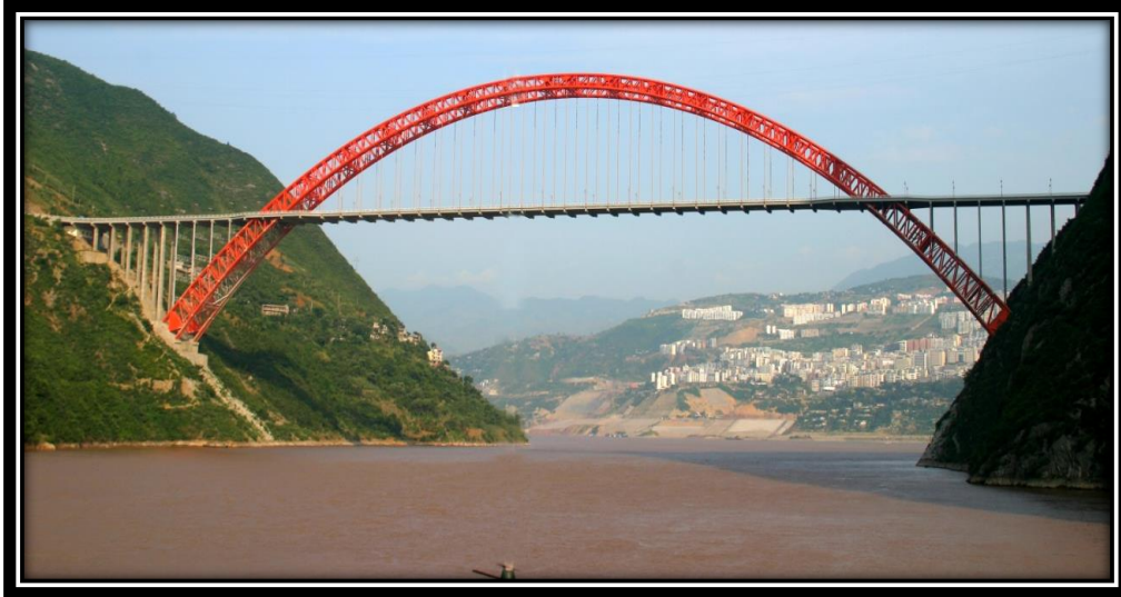
Εικόνα 2.9: Γέφυρα Wushan Yangtze (Κίνα) (wikipedia)
