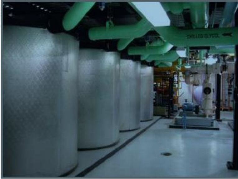
Σχήμα 6.1 Εγκατάσταση Ice on Coil [6].
