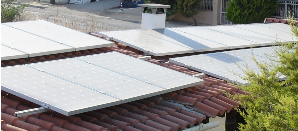
Εικόνα 4.1: Σκίαση από καπναγωγό τζακιού.
