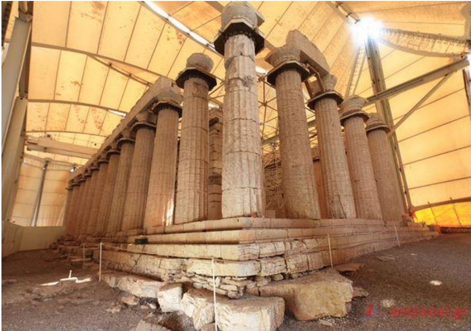
Εικόνα 1.4 : Αναστήλωση ναού Επικούριου Απόλλωνα
