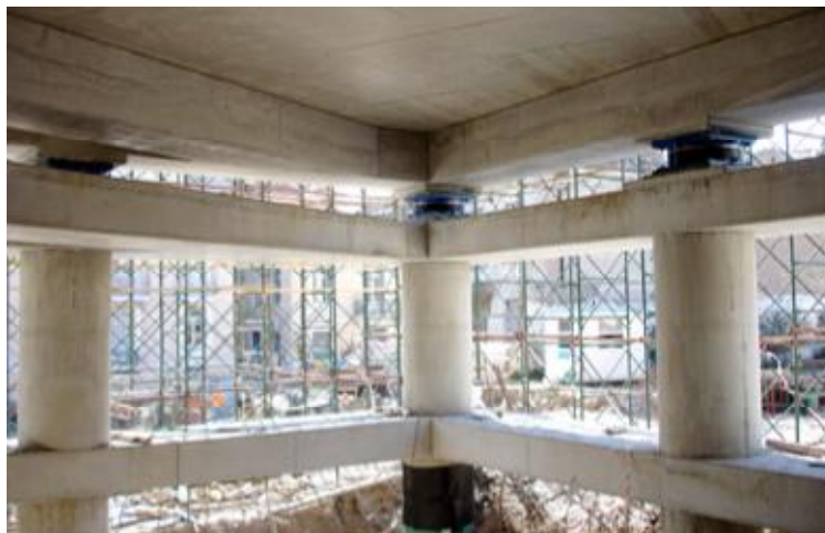
Εικόνα 2.9: Εφέδρανα ολίσθησης στο Μουσείο της Ακρόπολης
