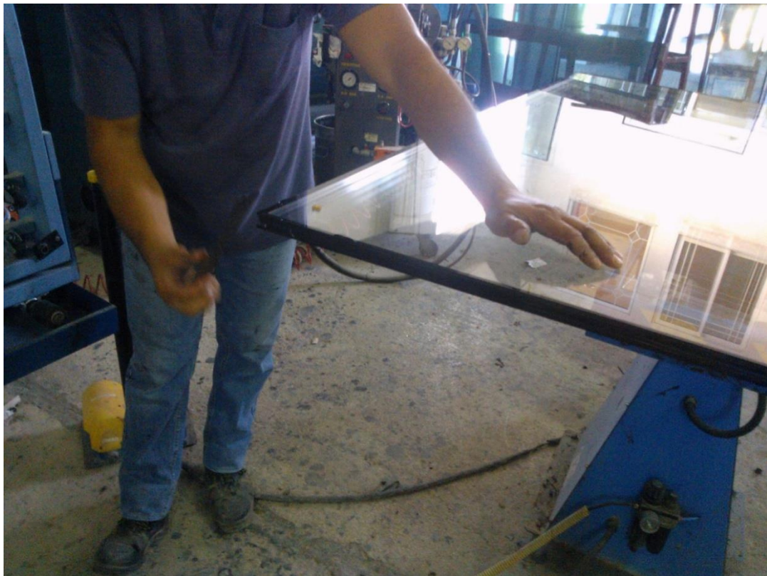
Εικόνα 4.6 Τοποθέτηση θειόκολλας περιμετρικά
