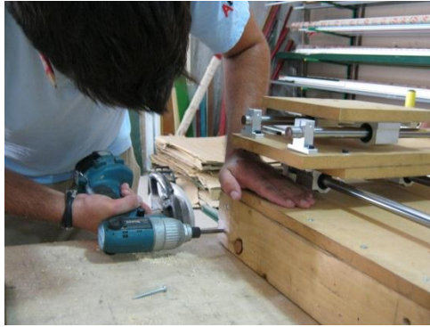
Σχήμα 64: Βιδώνω και μεταξύ τους τα επιμέρους καδρόνια.
