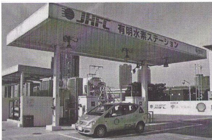
Εικόνα 4.9: Σταθμός τροφοδοσίας υγρού καυσίμου
