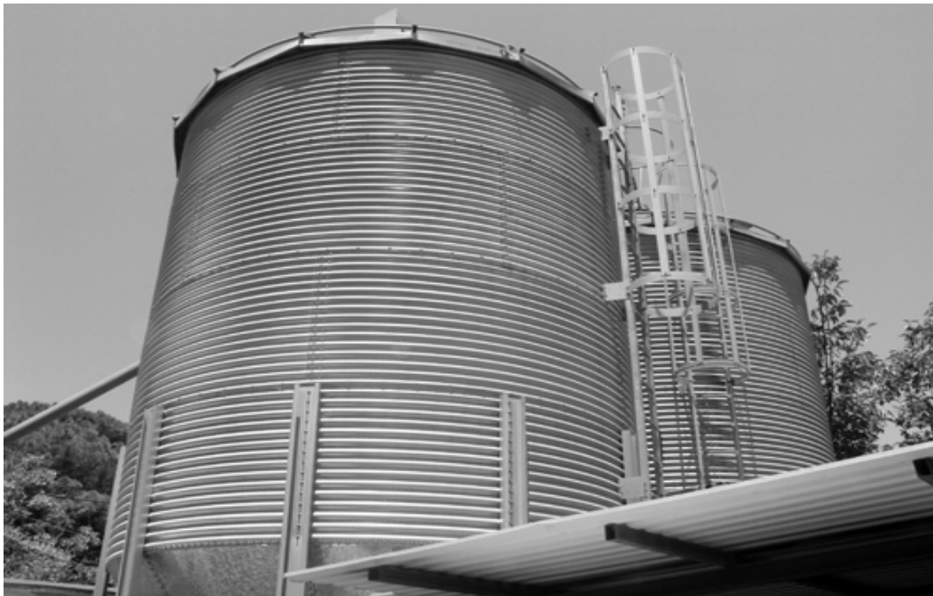
Εικόνα 5 (Μεταλλικό σιλό αποθήκευσης σιτηρών)
