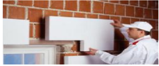
Εικόνα 3.3: Απεικόνιση τοποθέτησης EPS σε ανοίγματα.
