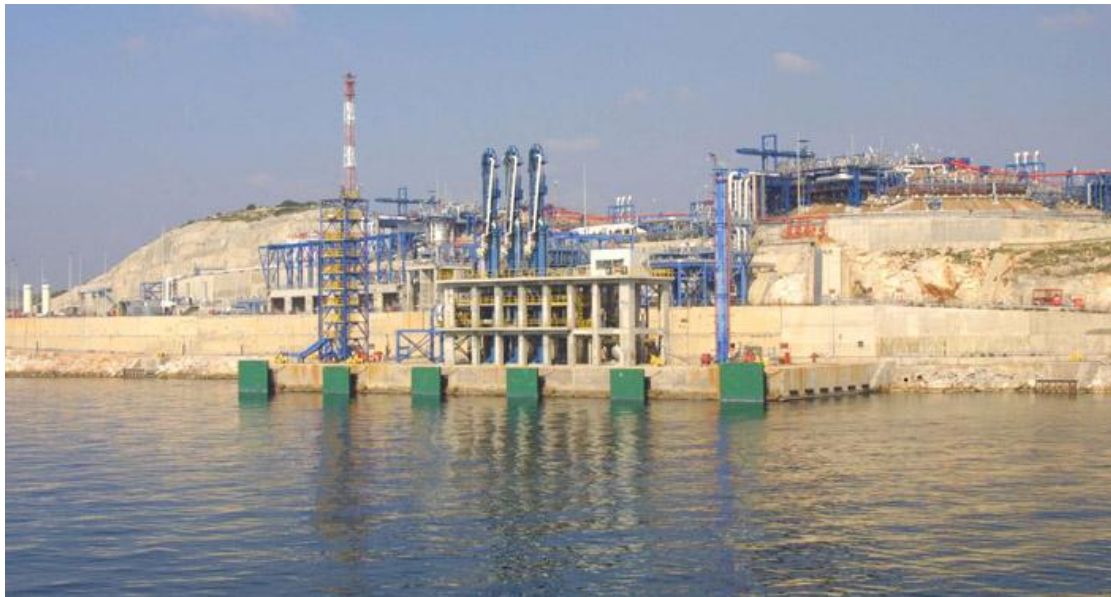
Εικόνα.1.1: Ο σταθμός υγροποιημένου φυσικού αερίου στη Ρεβιθούσα
