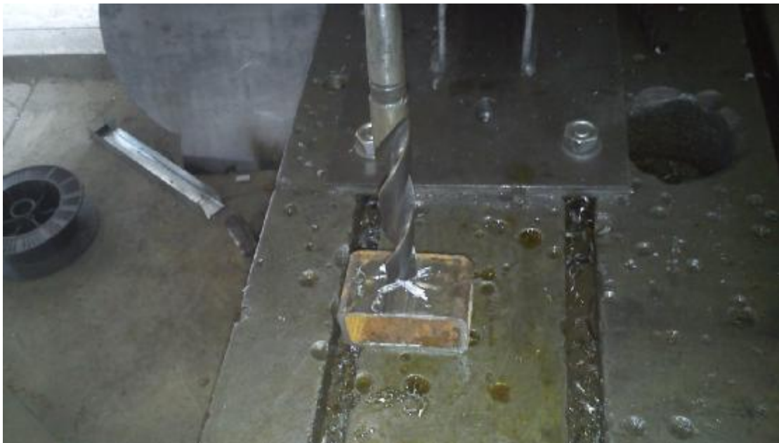
Εικόνα 10: Κοπή και διάτρηση κοιλοδοκού
