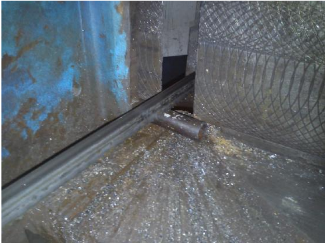
Εικόνα 30: Κοπή σωλήνα προέκτασης για την στήριξη των φωτοπυλών
