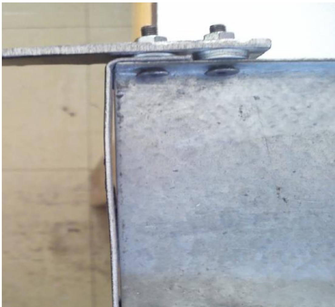
Εικόνα 16: Δοκιμή σύνδεσης πελμάτων-διαδρόμου
