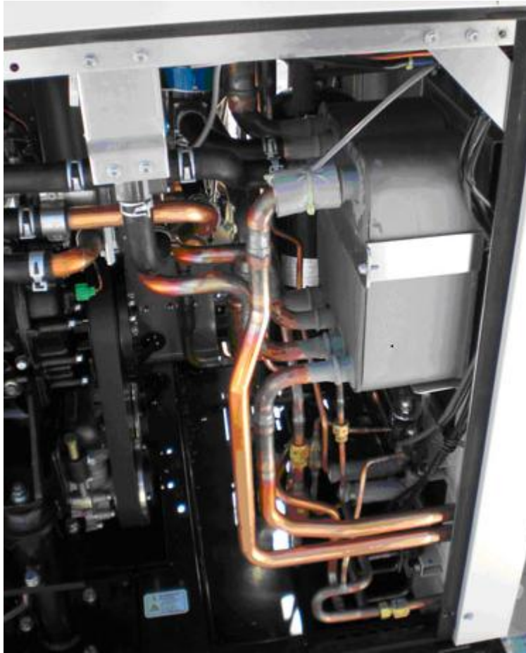
ΦΩΤΟΓΡΑΦΙΑ Νο 3: Ο ΠΡΩΤΟΣ ΕΝΑΛΛΑΚΤΗΣ ΠΑΡΑΓΕΙ ΖΕΣΤΟ ΝΕΡΟ ΧΡΗΣΗΣ – Ο ΔΕΥΤΕΡΟΣ ΕΞΑΤΜΙΖΕΙ ΤΟ ΦΡΕΟΝ ΣΕ ΠΟΛΥ ΧΑΜΗΛΕΣ ΘΕΡΜΟΚΡΑΣΙΕΣ
