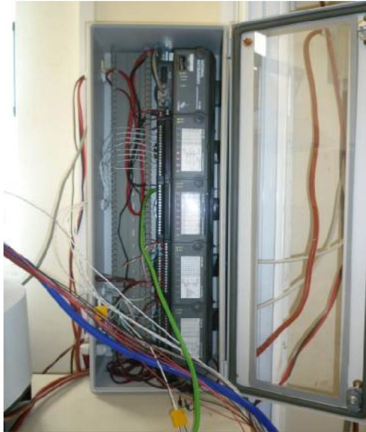
Εικόνα 4.14 : Διάταξη ελέγχου FieldPoint
