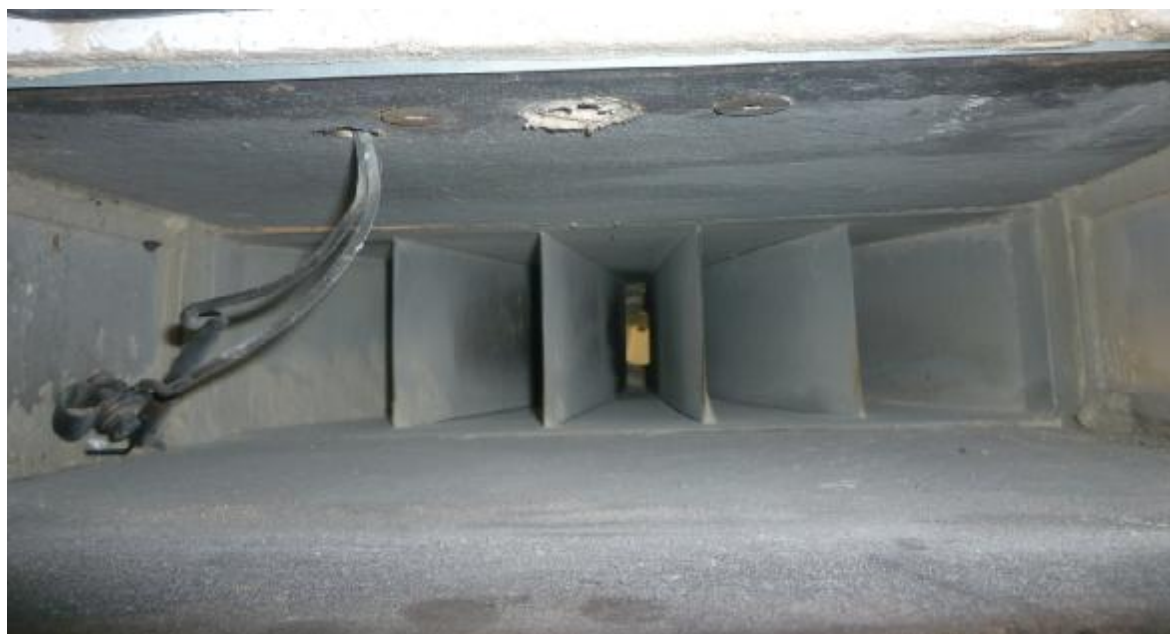
Εικόνα 4.6: Μορφή οδηγών πτερυγίων τοποθετημένα στον διαχύτη
