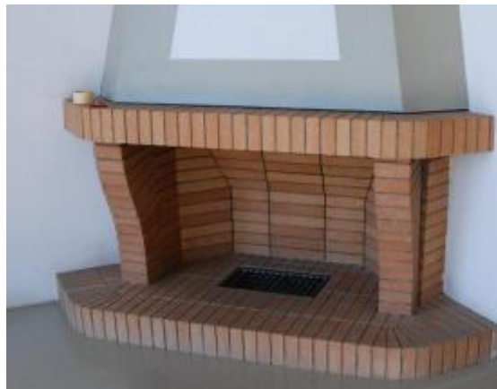
Εικ.1.7: Τυπική μορφή κτιστής εστίας με πυρότουβλο.
