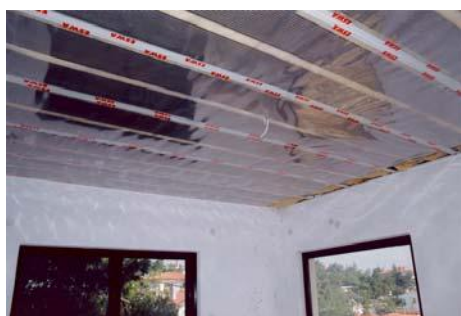
Σχήμα 25 Εγκατάσταση θέρμανσης οροφής [35]
