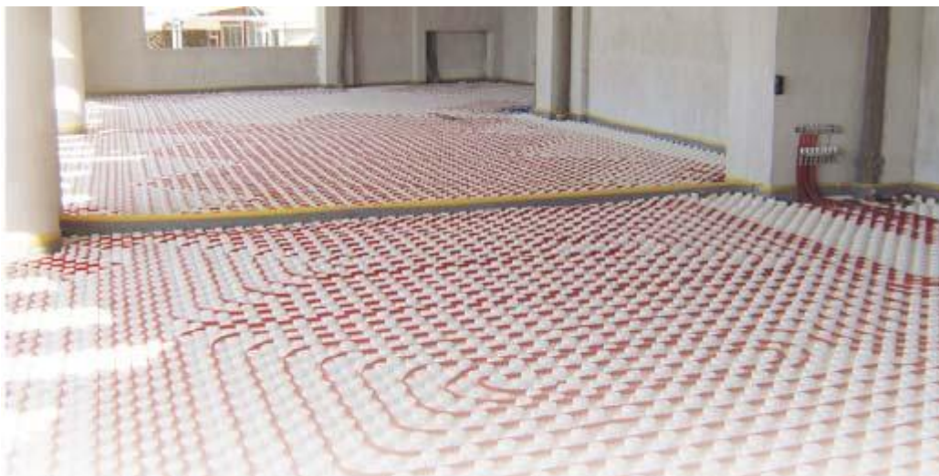
Σχήμα 21. Ενδοδαπέδια θέρμανση [33]
