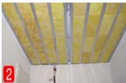
Σχήμα 24 α,β,γ,δ Εγκατάσταση θέρμανσης οροφής [34]
