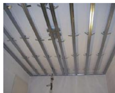
Σχήμα 25 Εγκατάσταση θέρμανσης οροφής [35]
