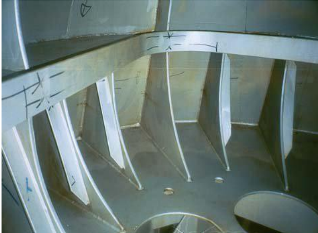
Εικόνα 10.5 Δεξαμενή μετά από πενταετή χρήση
