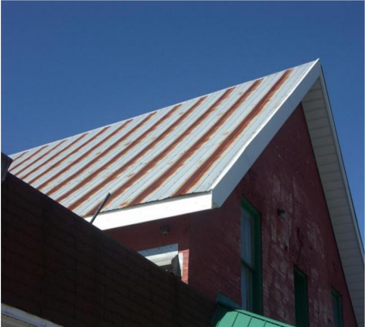
Εικόνα 3.3 Γαλβανισμένη οροφή με ομοιόμορφα κατανεμημένες ζώνες σκουριάς
