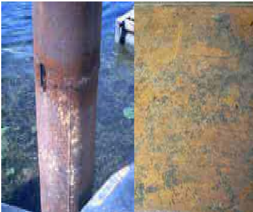
Εικόνα 3.1 Γενική διάβρωση
