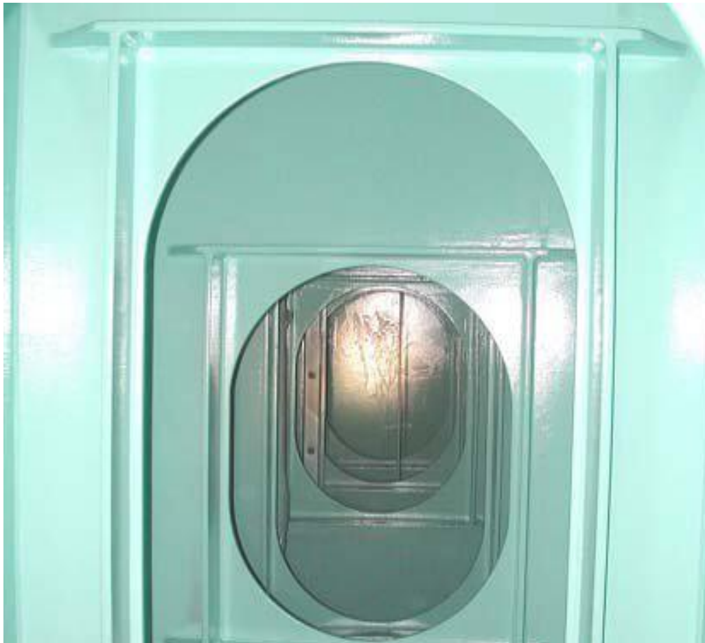
Εικόνα 10.4 Αχρησιμοποίητη, πρόσφατα επικαλυμμένη δεξαμενή
